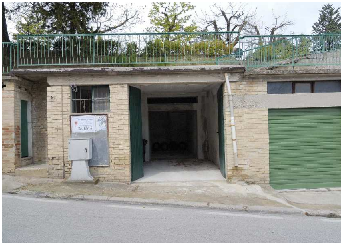
Foto N.: 1 Lato sud su Viale Adriatico
