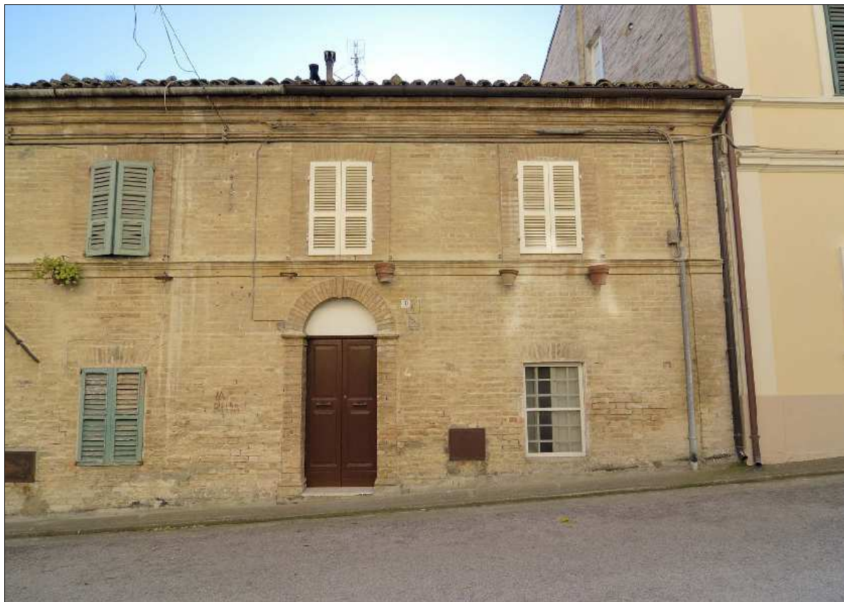
Foto N.: 1 Lato nord su Via Indipendenza
