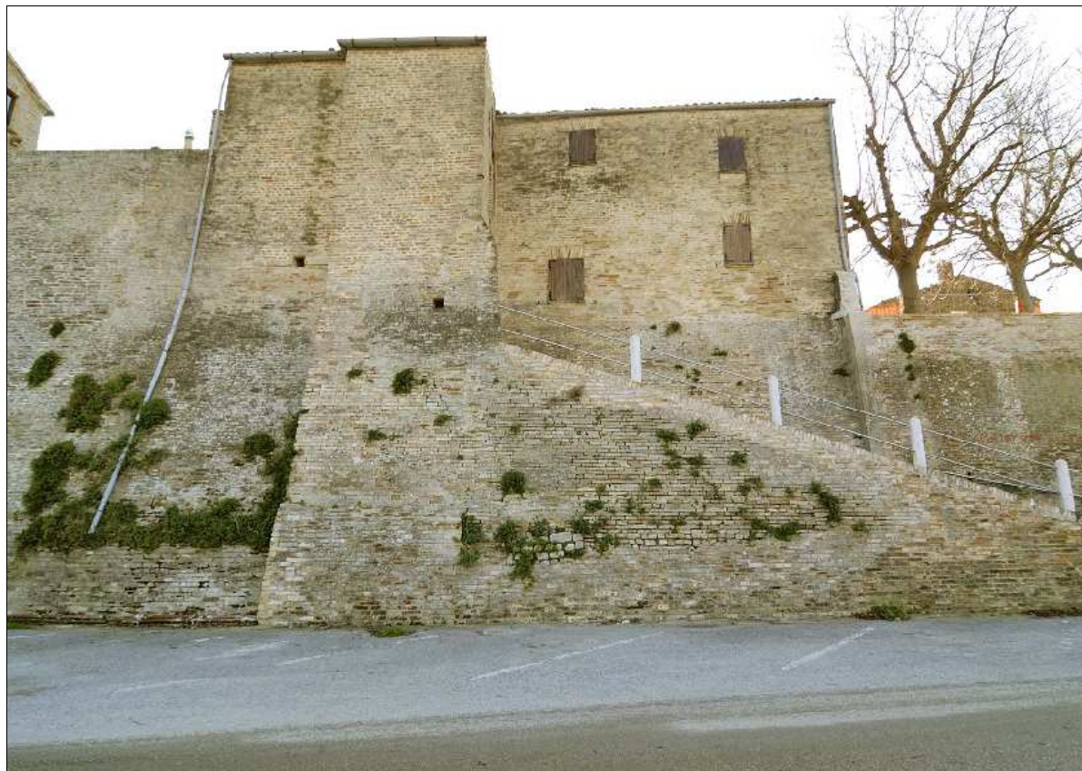
Foto N.: 3 Lato nord su Via Polini
