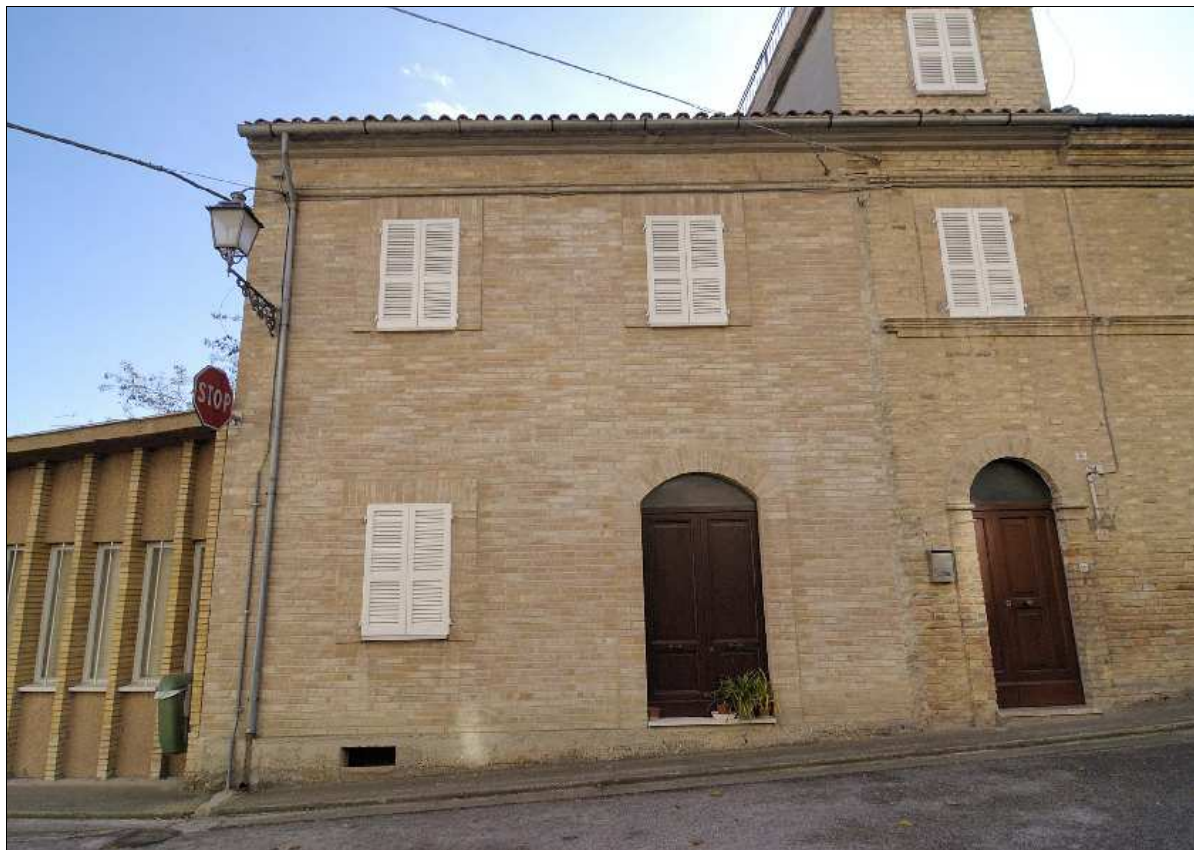
Foto N.: 1 Lato nord su Via Indipendenza
