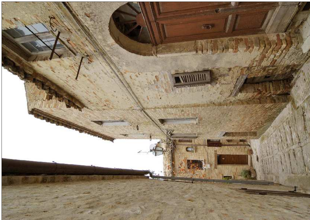
Foto N.: 1 Lato ovest su Via Pichelli
