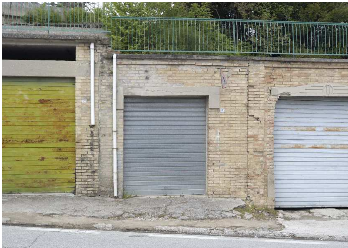
Foto N.: 1 Lato sud su Viale Adriatico
