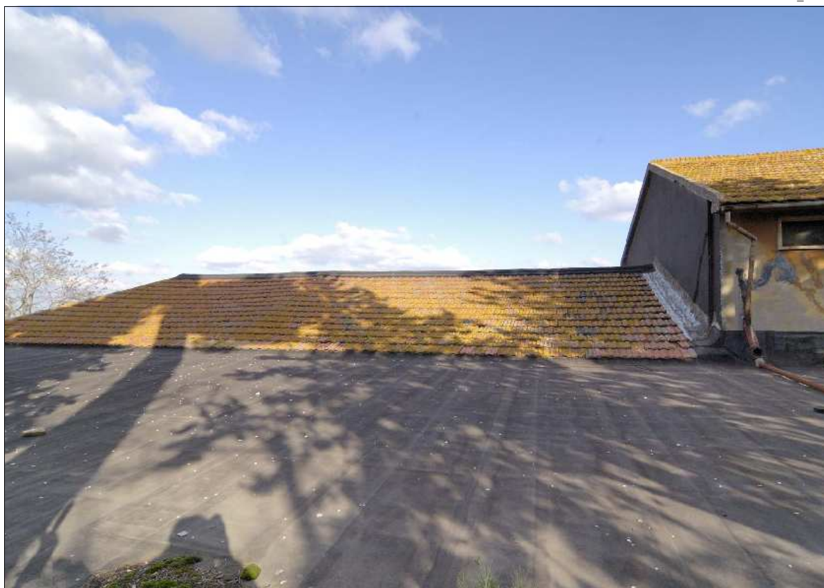
Foto N.: 4 Lato ovest
