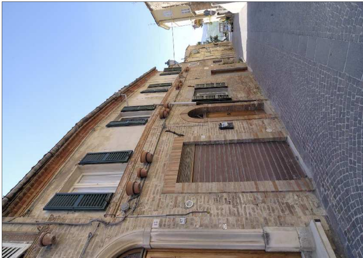
Foto N.: 2 Lato nord su Via Roma
