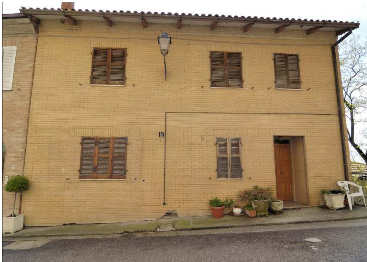
Foto N.: 1 Lato nord su Via Indipendenza
