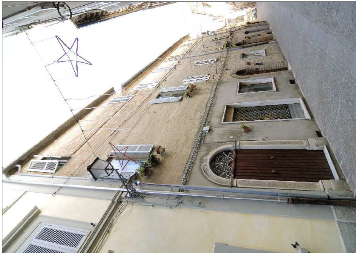
Foto N.: 2 Lato nord su Via Roma
