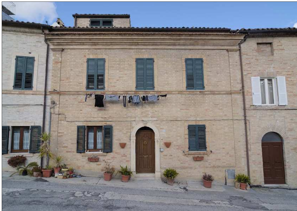
Foto N.: 1 Lato sud
