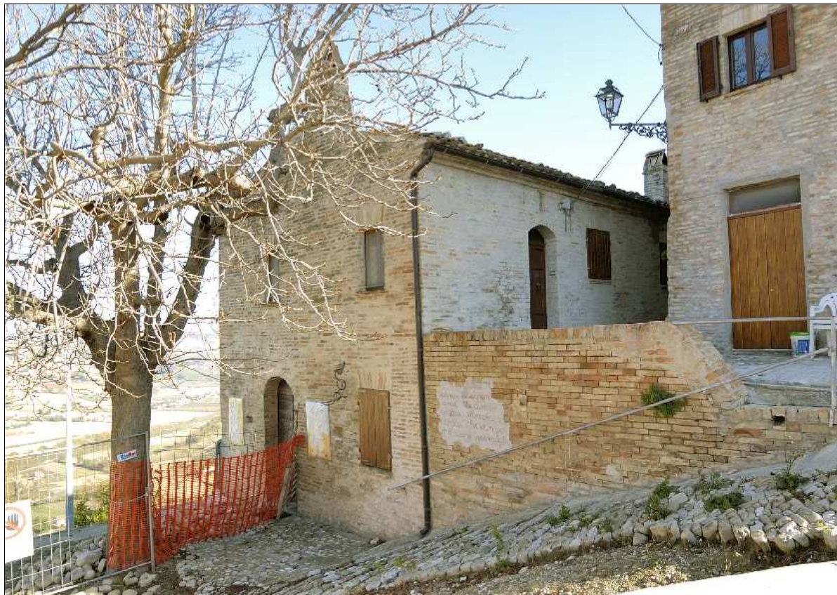
Foto N.: 2 Lato ovest
