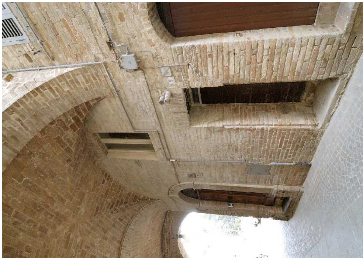
Foto N.: 5 Lato nord su passaggio coperto di Via C. Battisti
