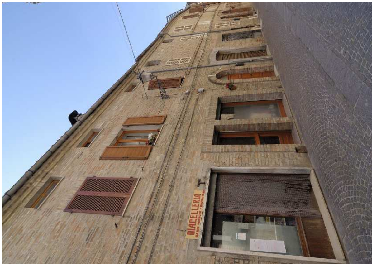
Foto N.: 2 Lato nord su Via Roma
