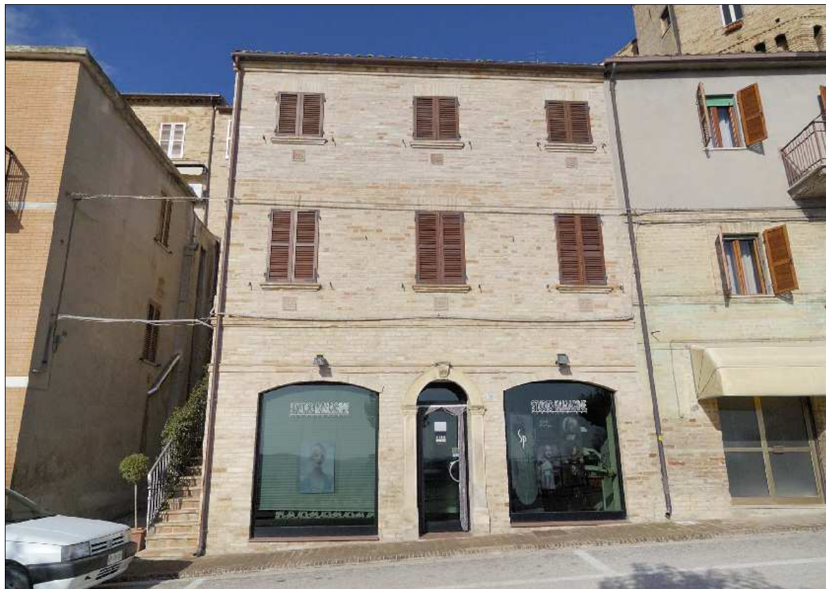
Foto N.: 1 Lato sud su Via XX Settembre
