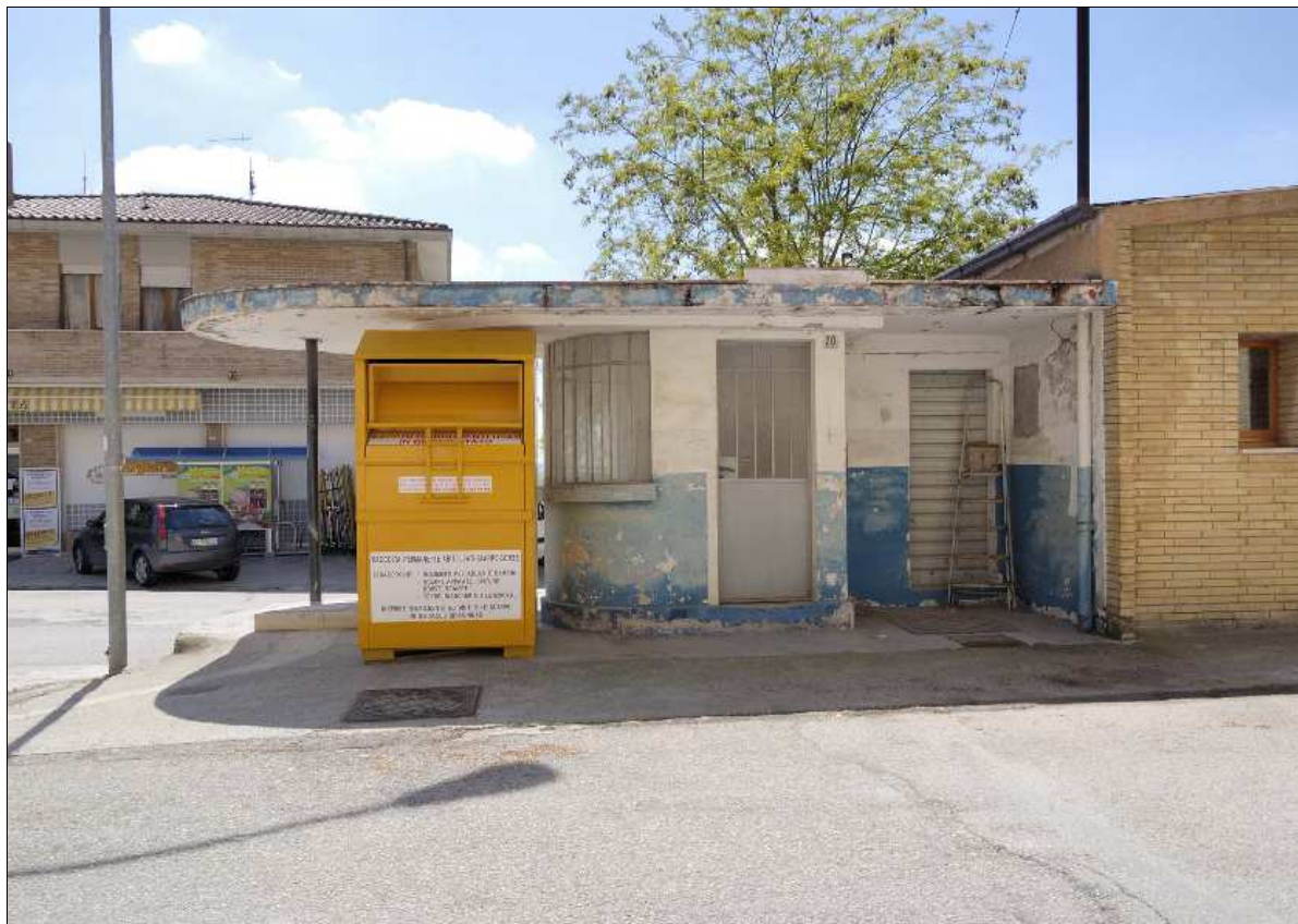
Foto N.: 1 Lato nord su Via Indipendenza
