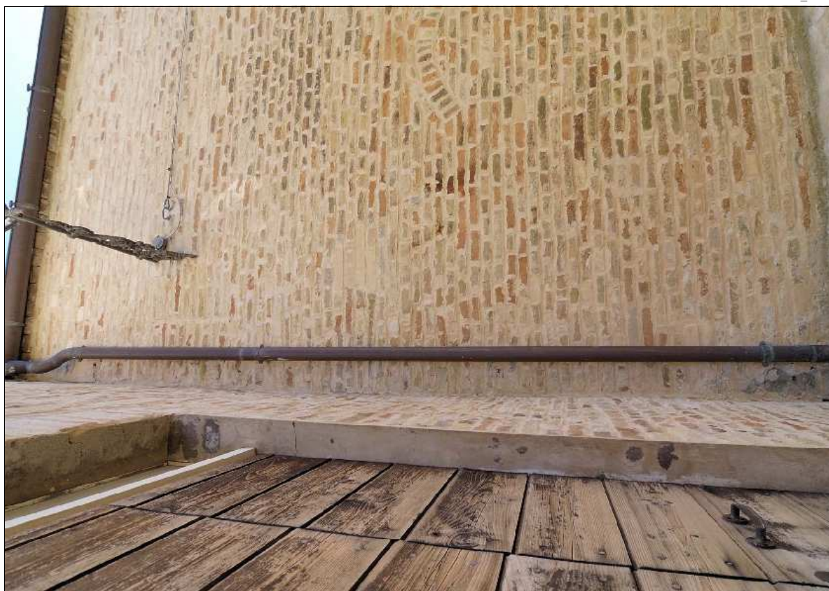
Foto N.: 4 Lato ovest in sequenza con la n. 3
