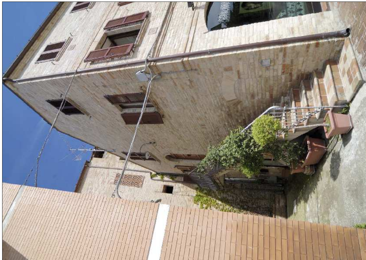
Foto N.: 2 Lato ovest
