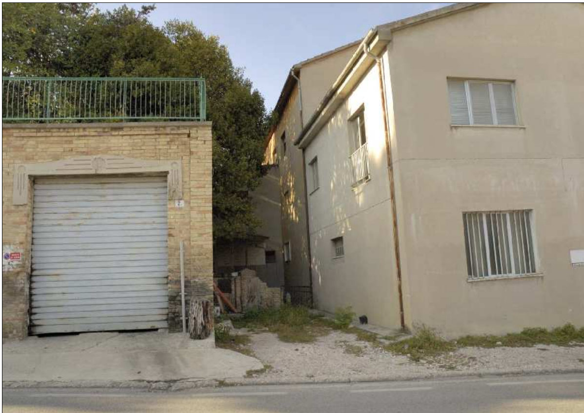
Foto N.: 2 Lato ovest
