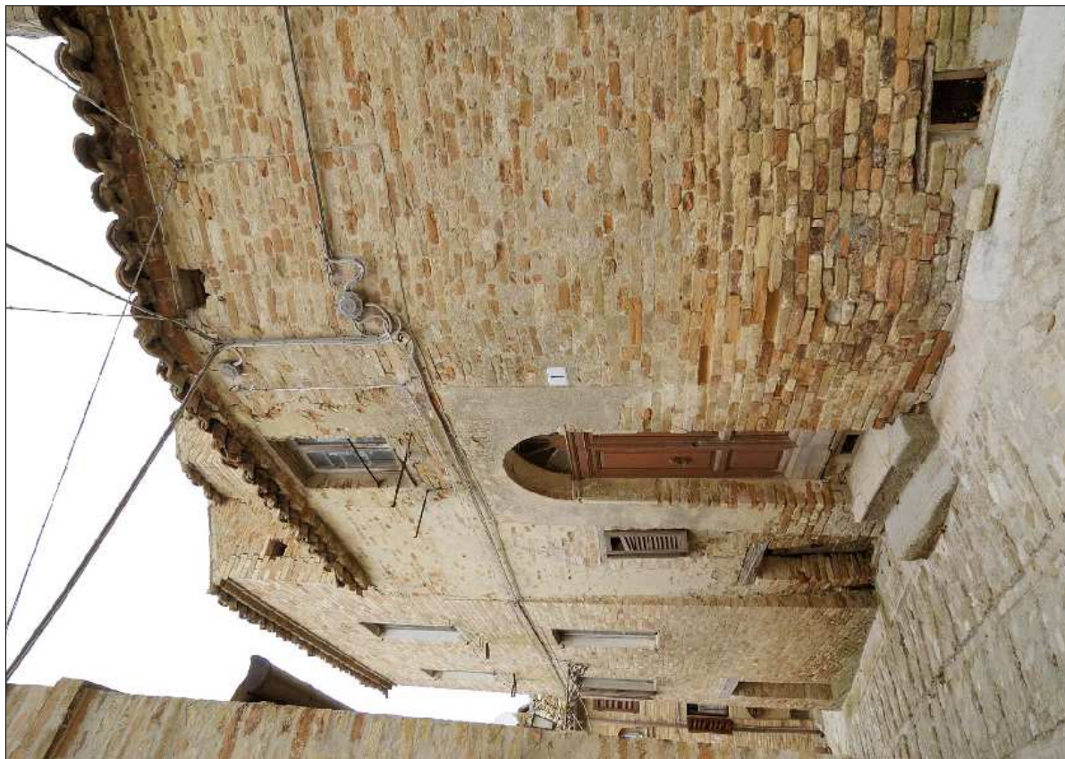
Foto N.: 3 Lato ovest su Via Pichelli
