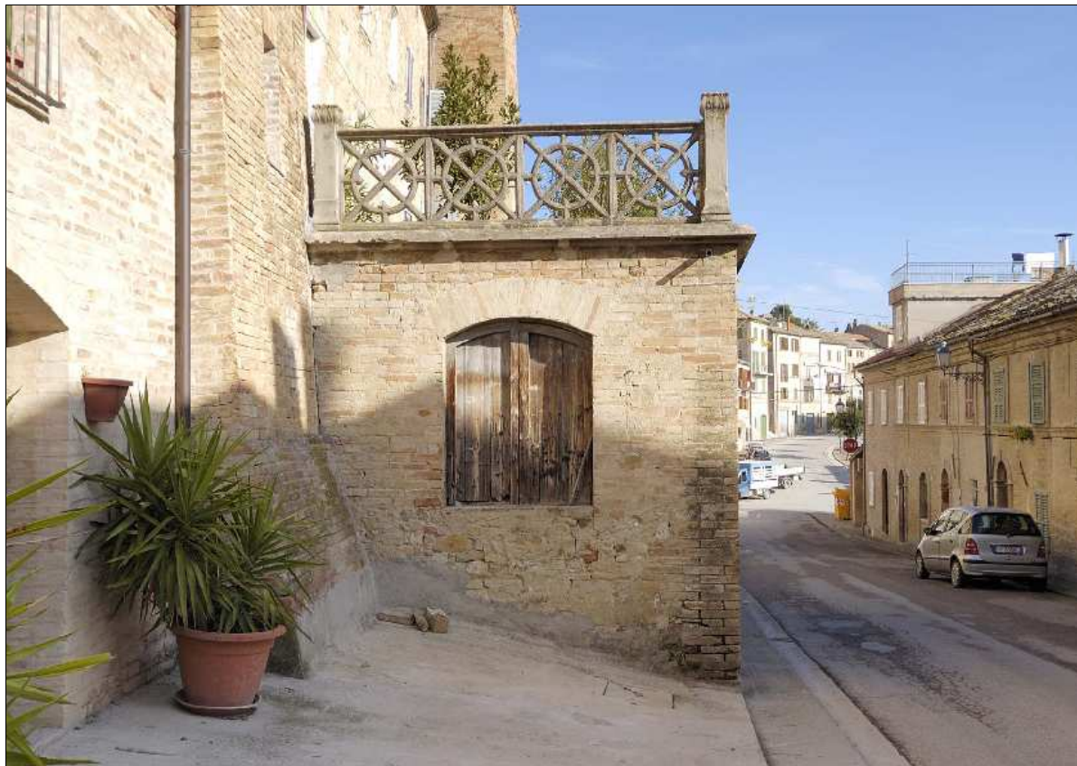
Foto N.: 2 Lato ovest
