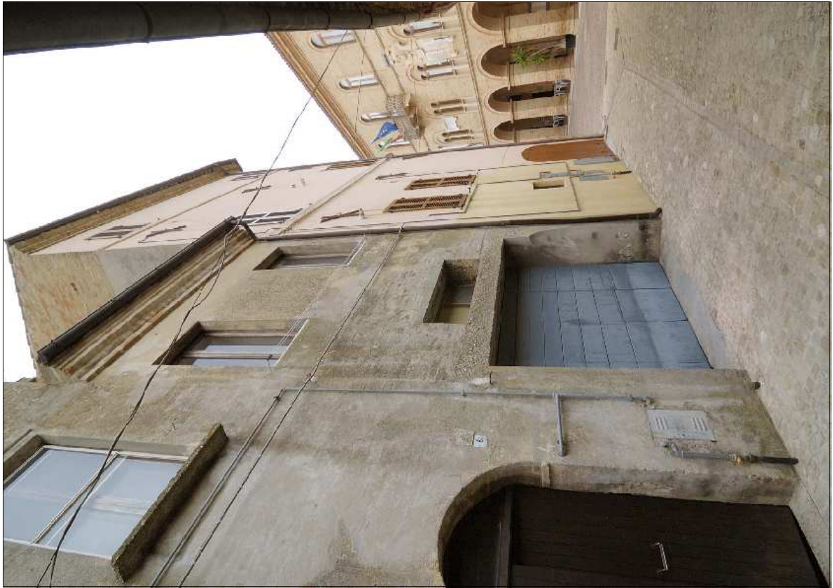
Foto N.: 5 Lato nord su Via G. Garibaldi
