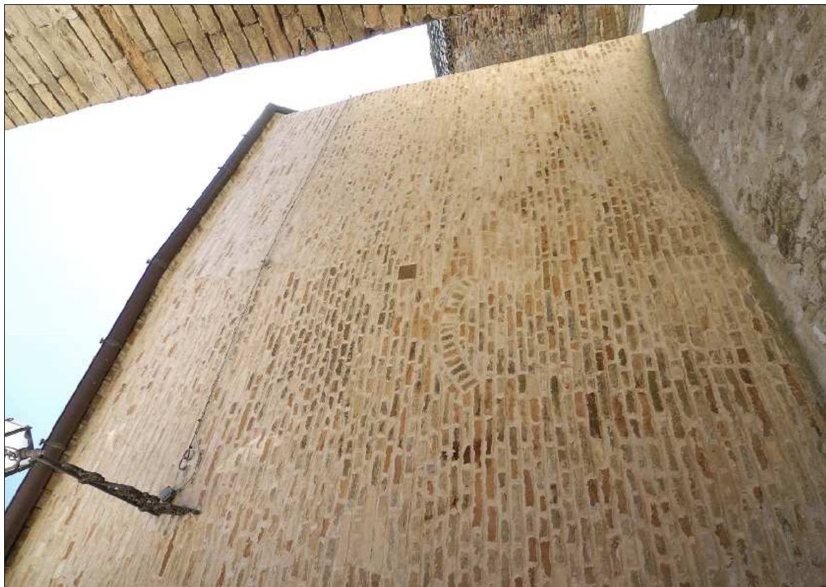
Foto N.: 3 Lato ovest in sequenza con la n. 4
