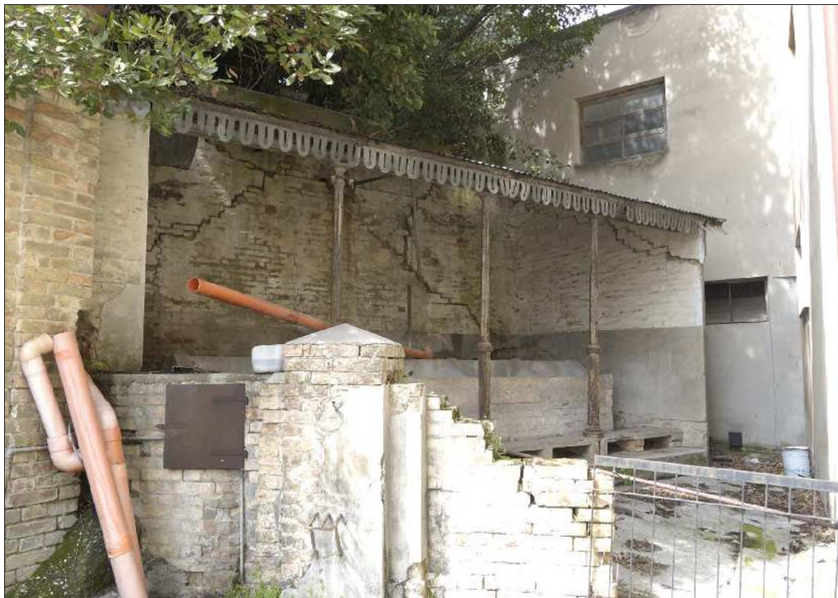
Foto N.: 1 Lato est
