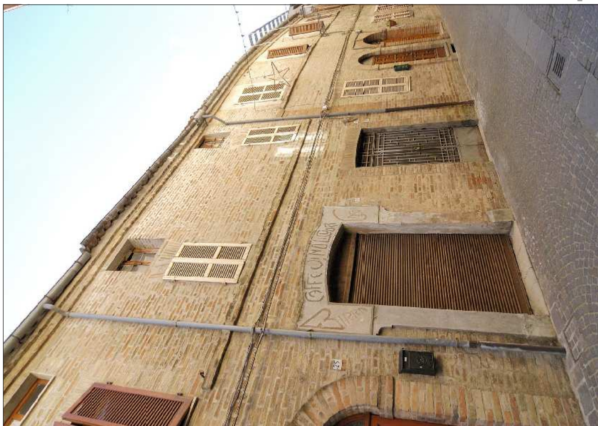
Foto N.: 4 Lato nord su Via Roma
