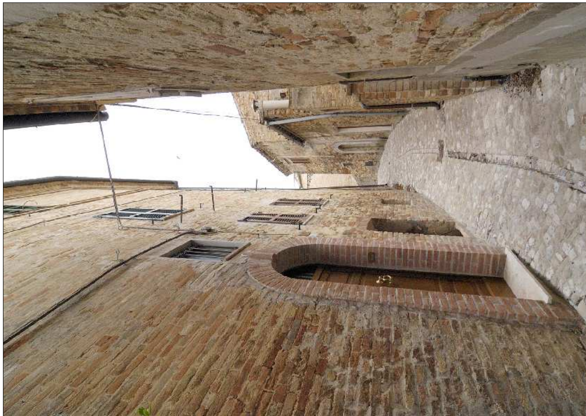
Foto N.: 2 Lato sud su Via Boffo
