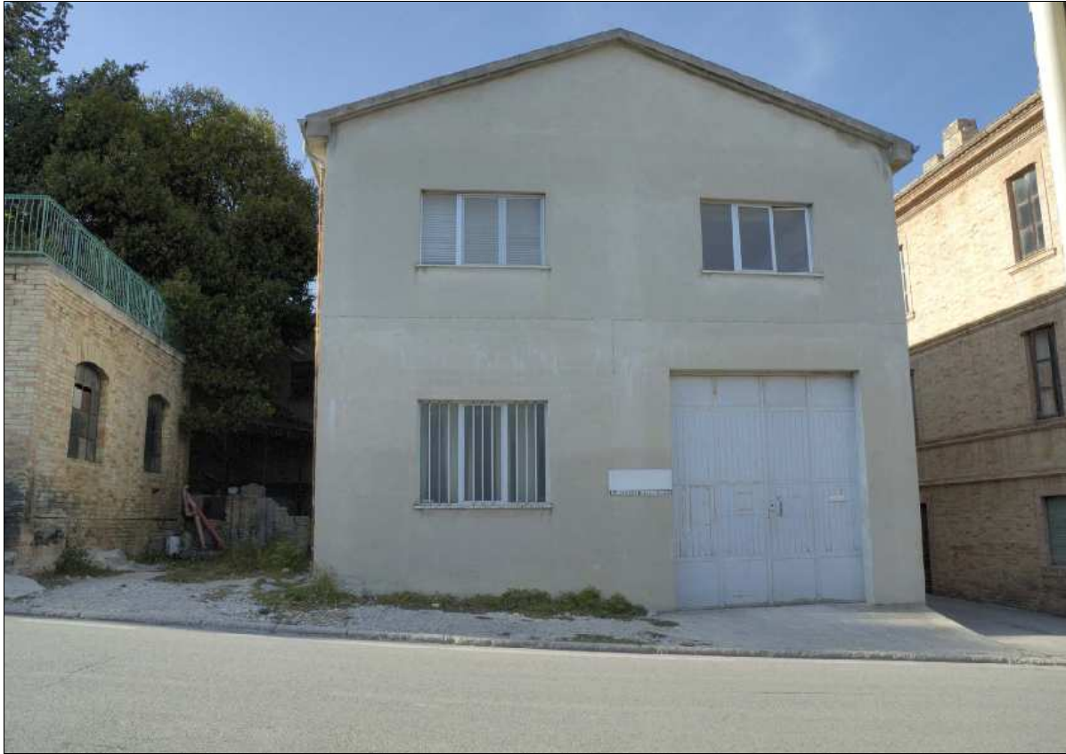
Foto N.: 1 Lato sud su Viale Adriatico
