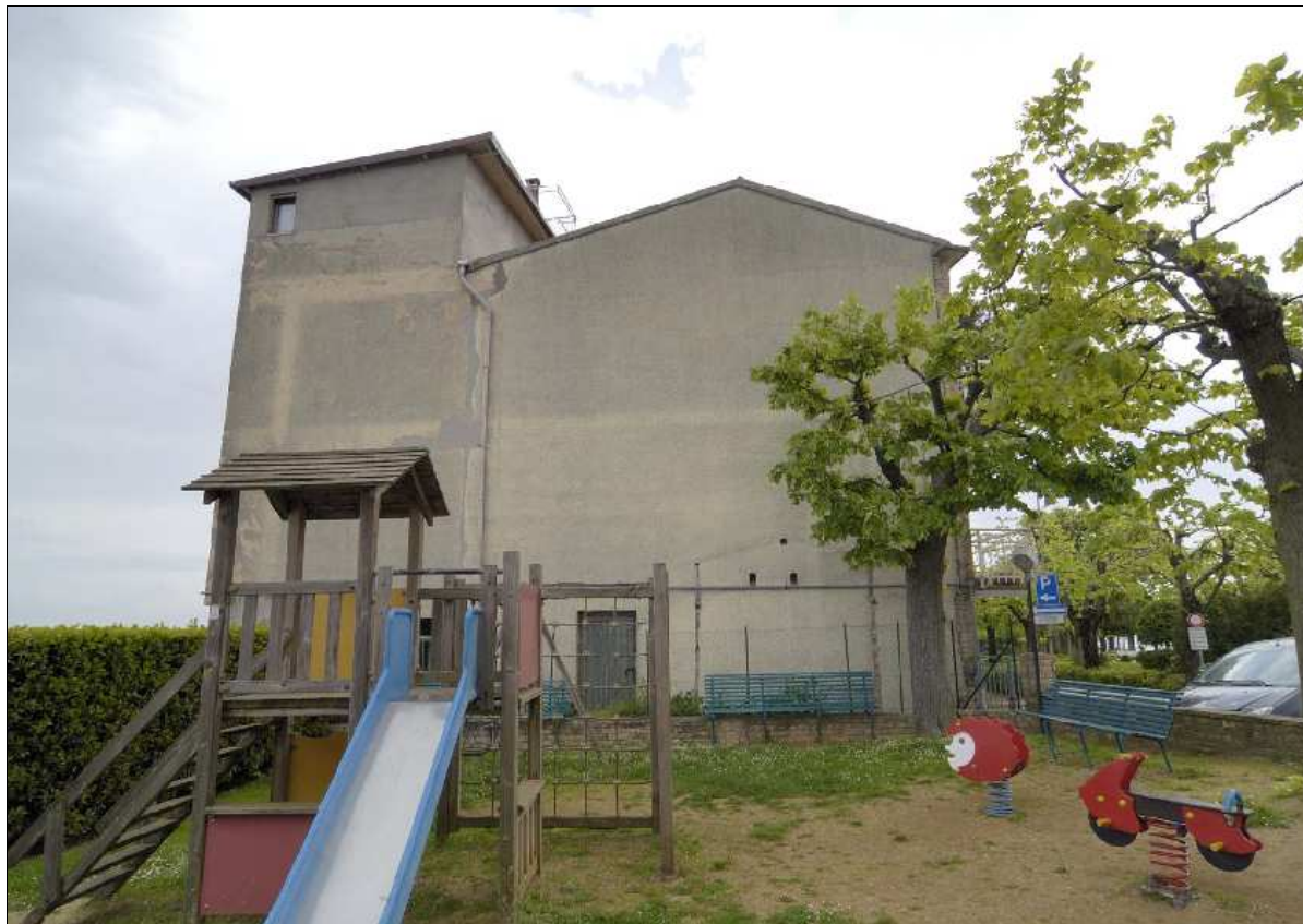
Foto N.: 2 Lato ovest
