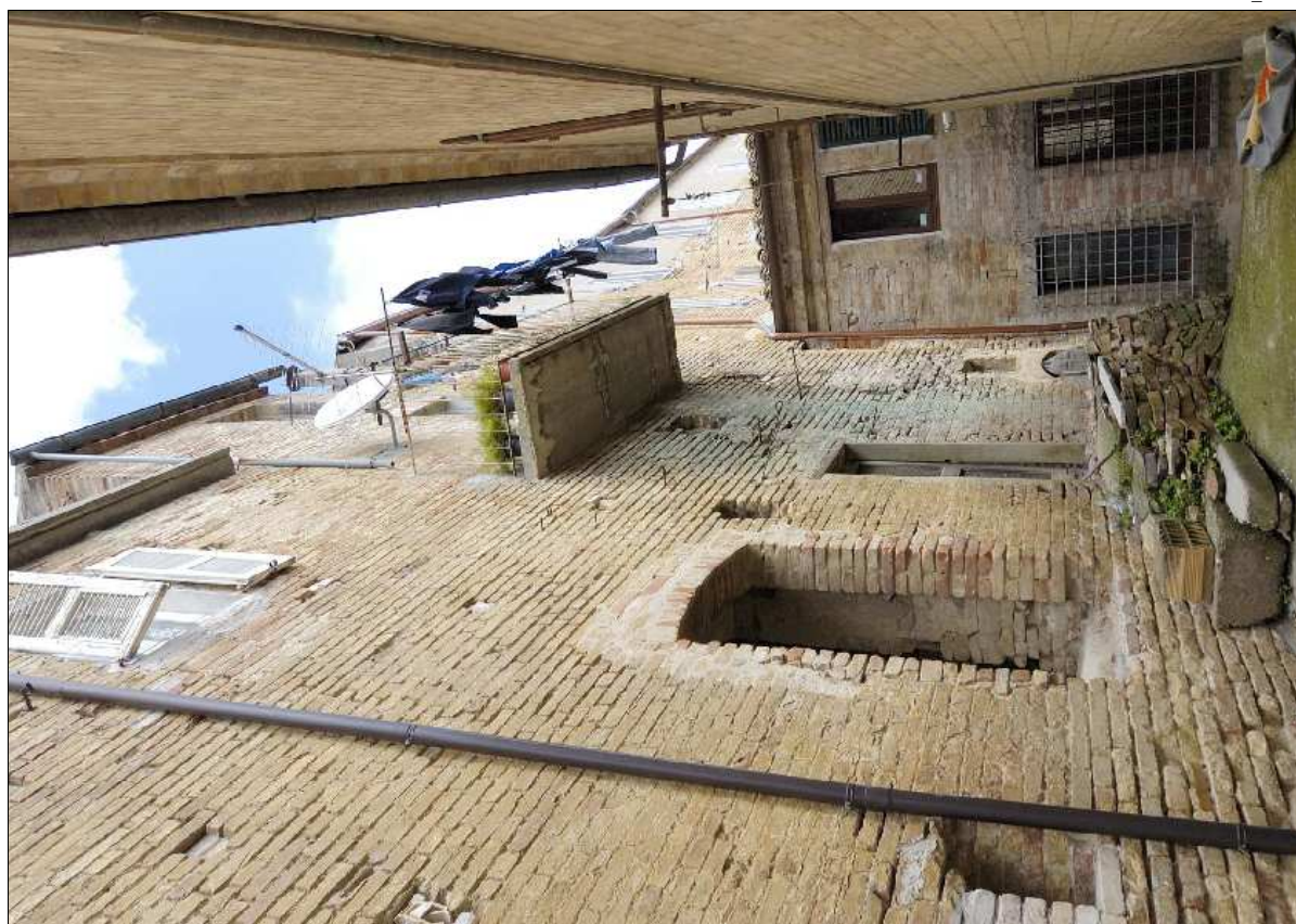
Foto N.: 3 Lato sud
