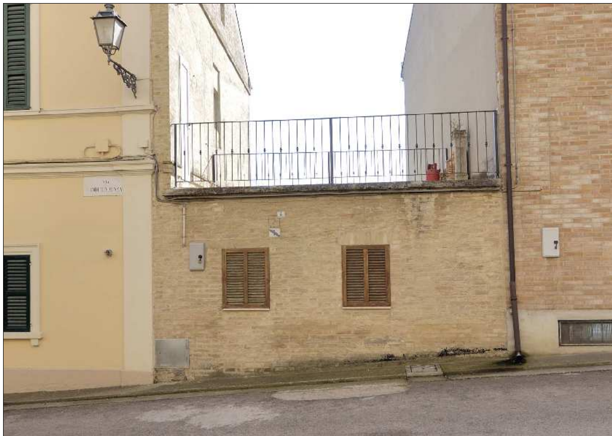
Foto N.: 1 Lato nord su Via Indipendenza
