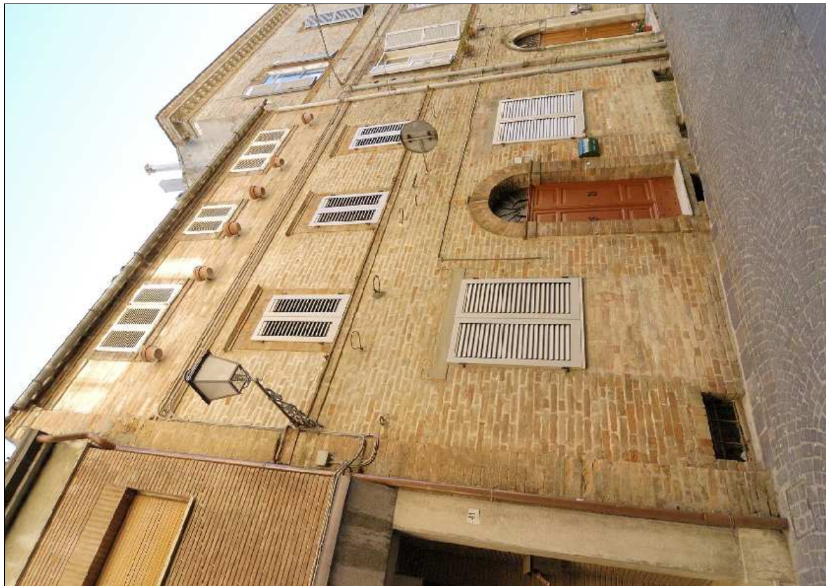
Foto N.: 2 Lato nord su Via Roma
