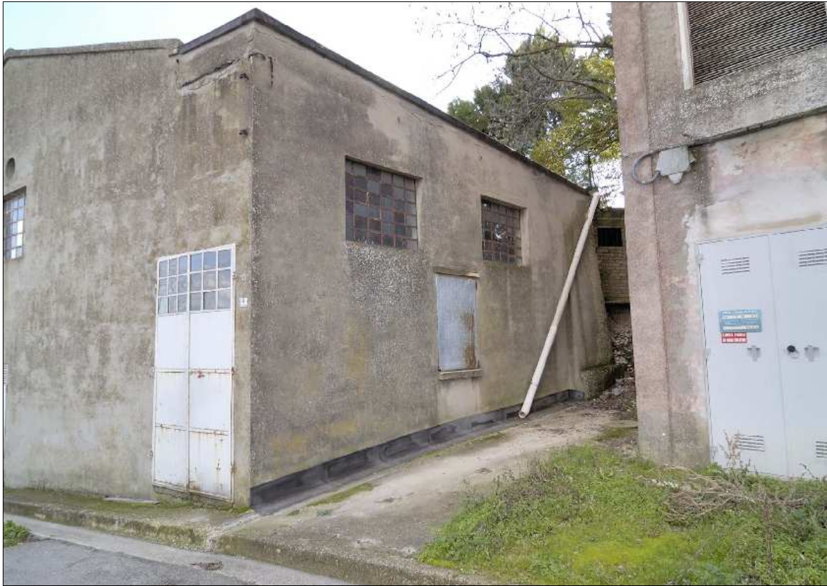
Foto N.: 5 Lato ovest
