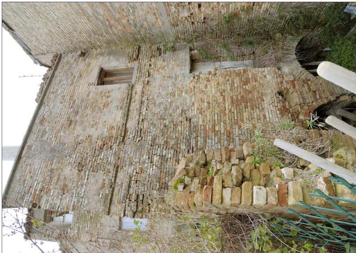
Foto N.: 3 Lato nord su corte
