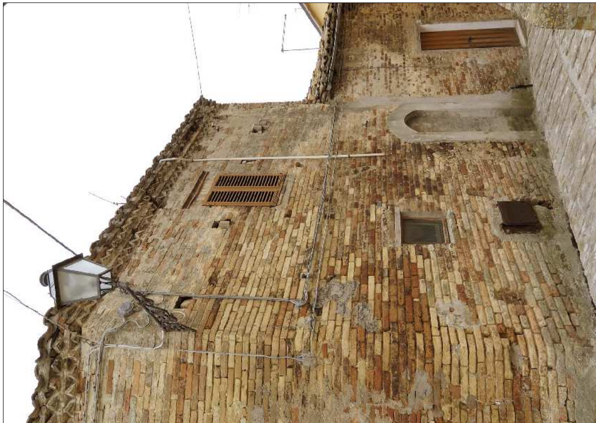
Foto N.: 2 Lato nord su Via Boffo
