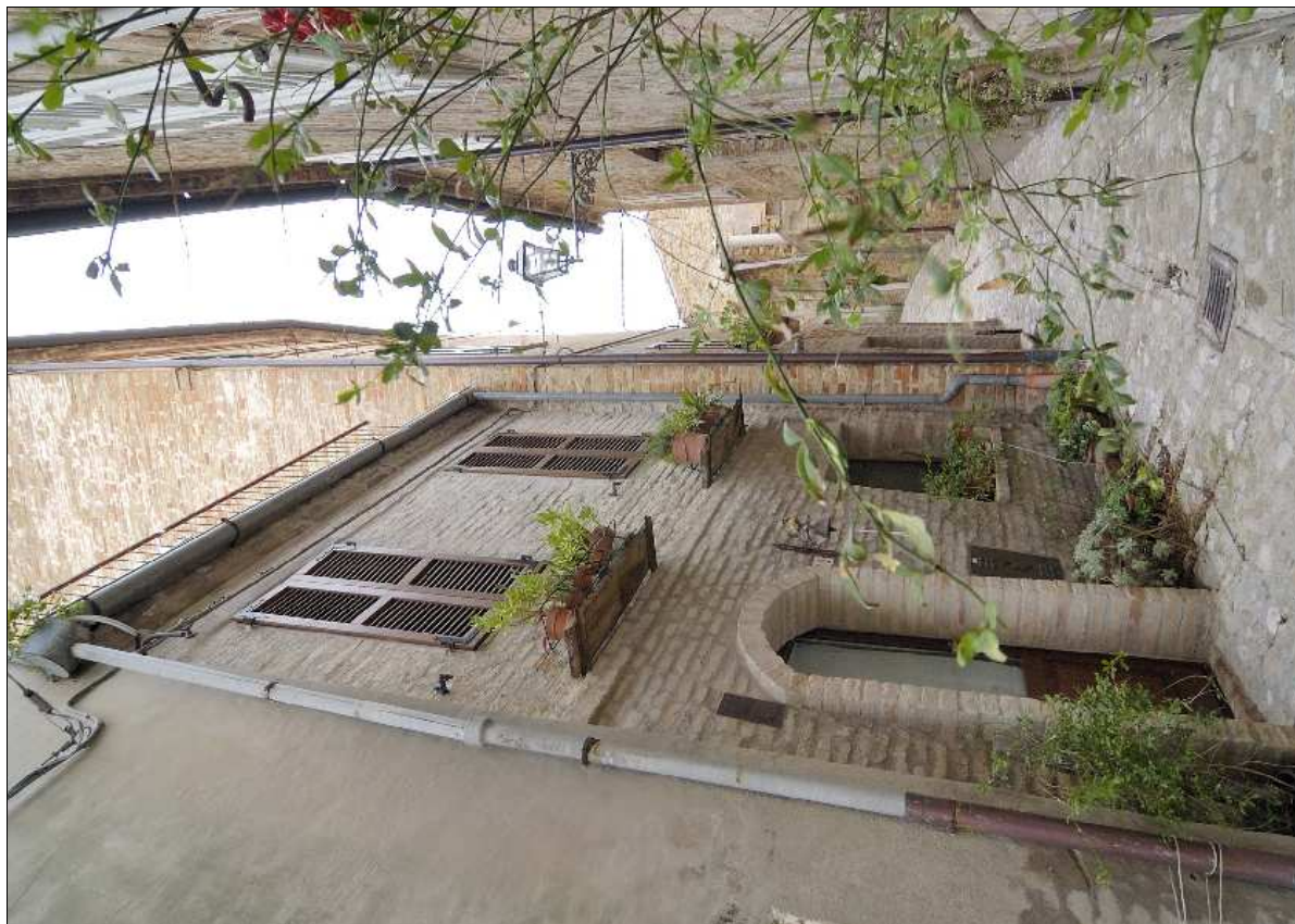
Foto N.: 1 Lato sud su Via Boffo
