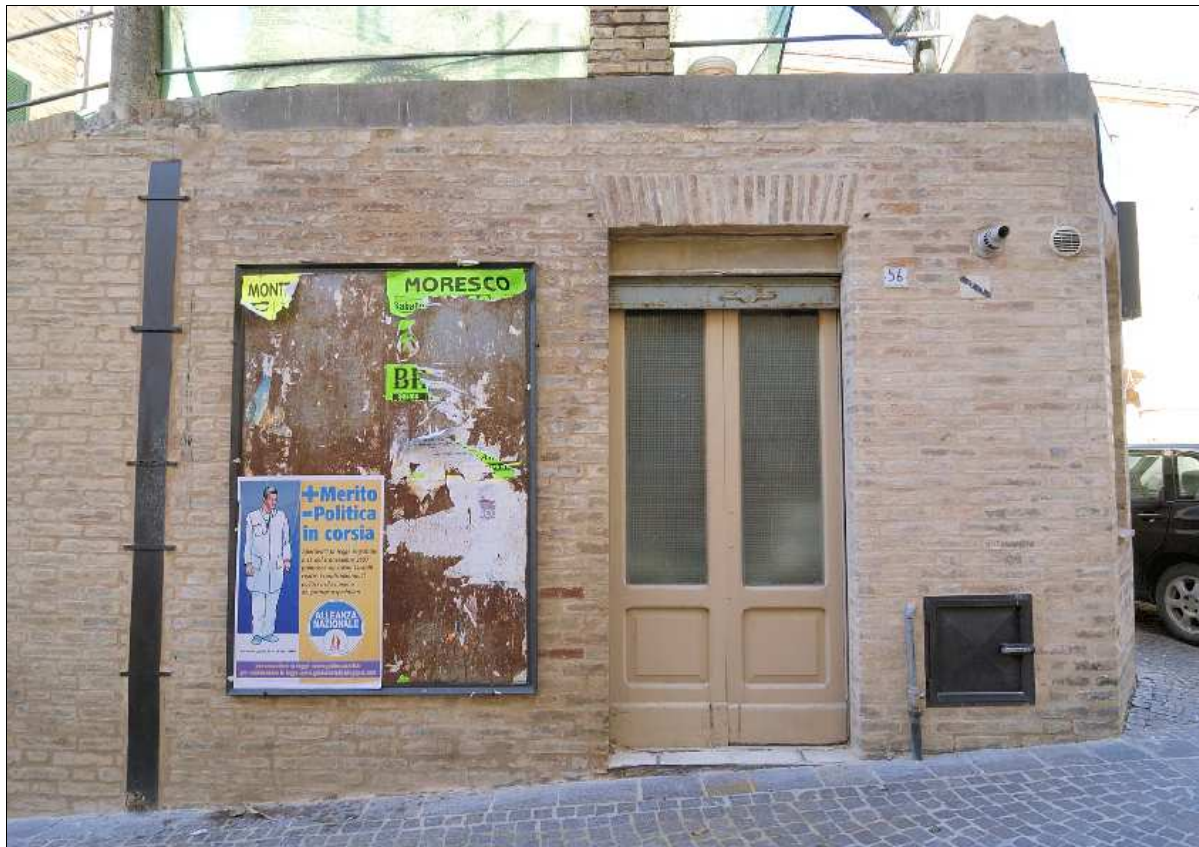
Foto N.: 2 Lato sud
