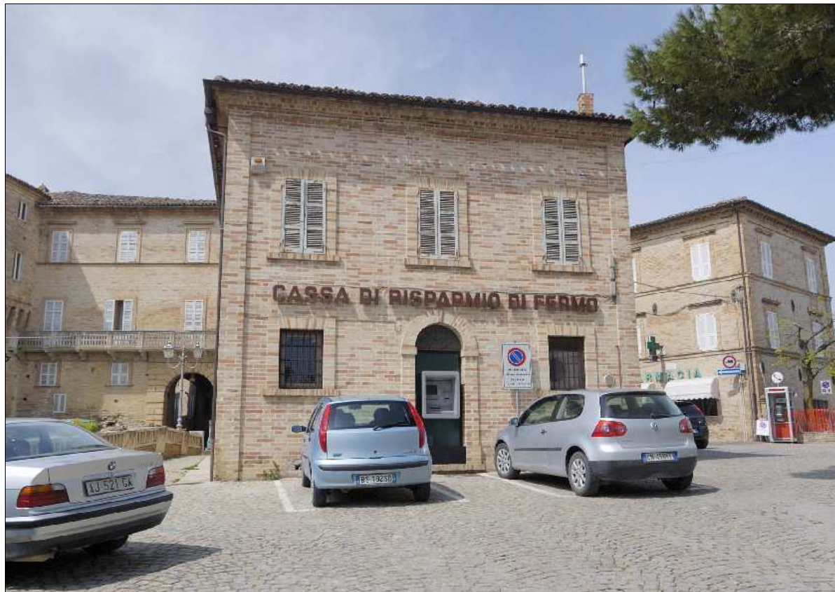
Foto N.: 2 Lato est
