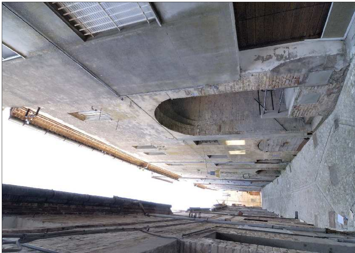
Foto N.: 3 Lato nord su Via Garibaldi
