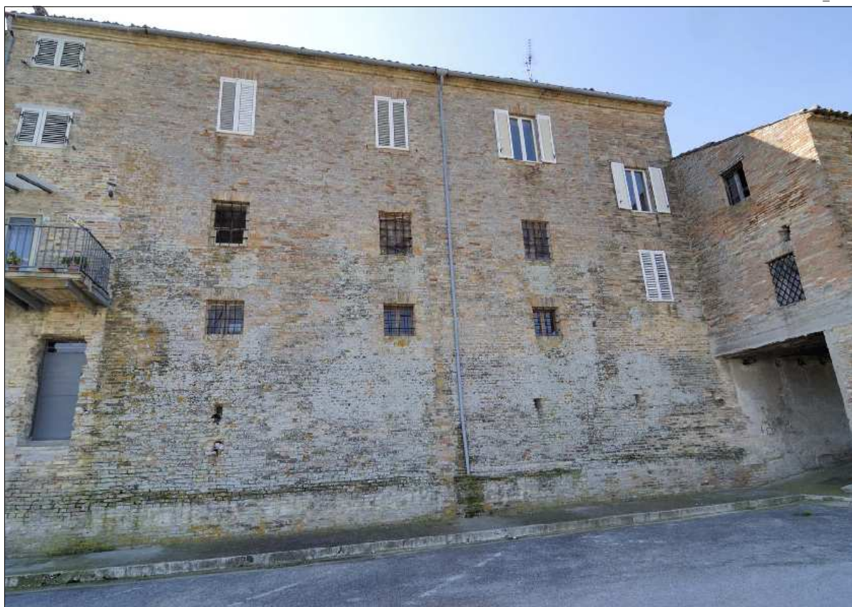
Foto N.: 4 Lato nord su Via Polini
