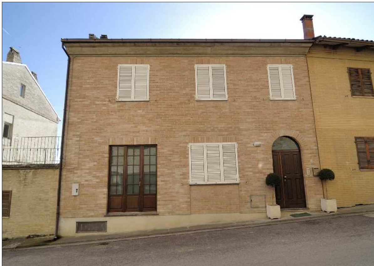
Foto N.: 1 Lato nord su Via Indipendenza
