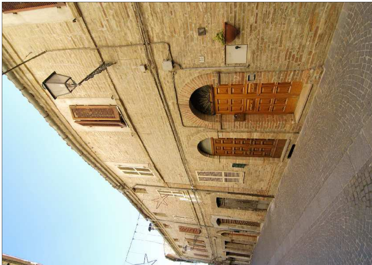
Foto N.: 1 Lato nord su Via Roma
