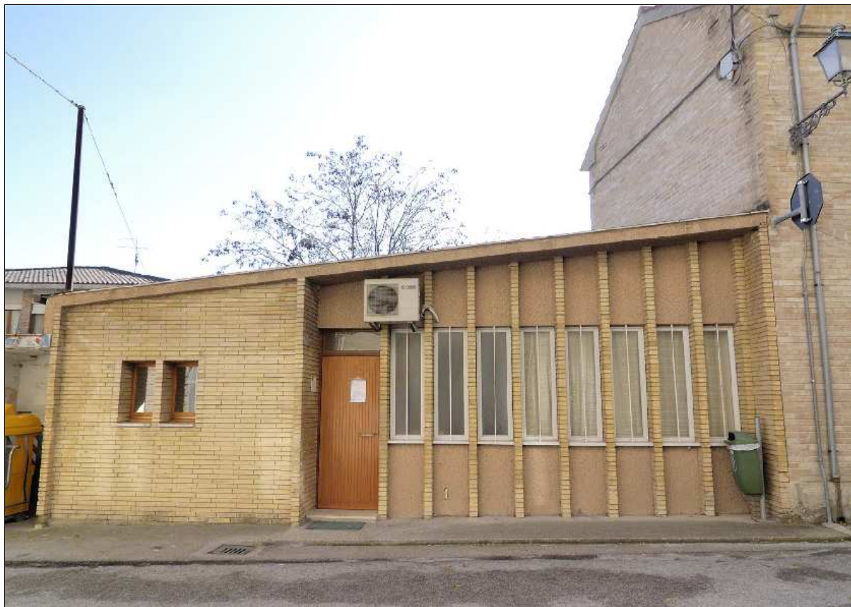
Foto N.: 1 Lato nord su Via Indipendenza
