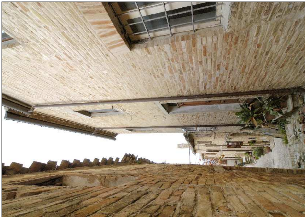
Foto N.: 7 Lato sud in sequenza con la n. 4 e 5
