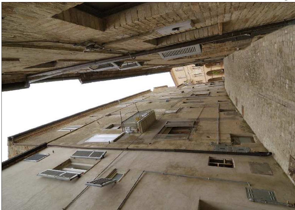
Foto N.: 4 Lato nord su Via Garibaldi
