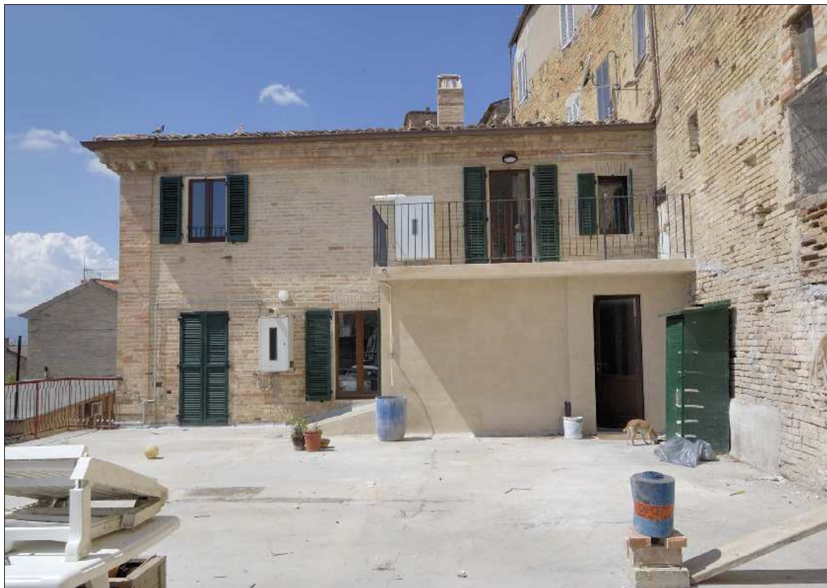
Foto N.: 3 Lato est
