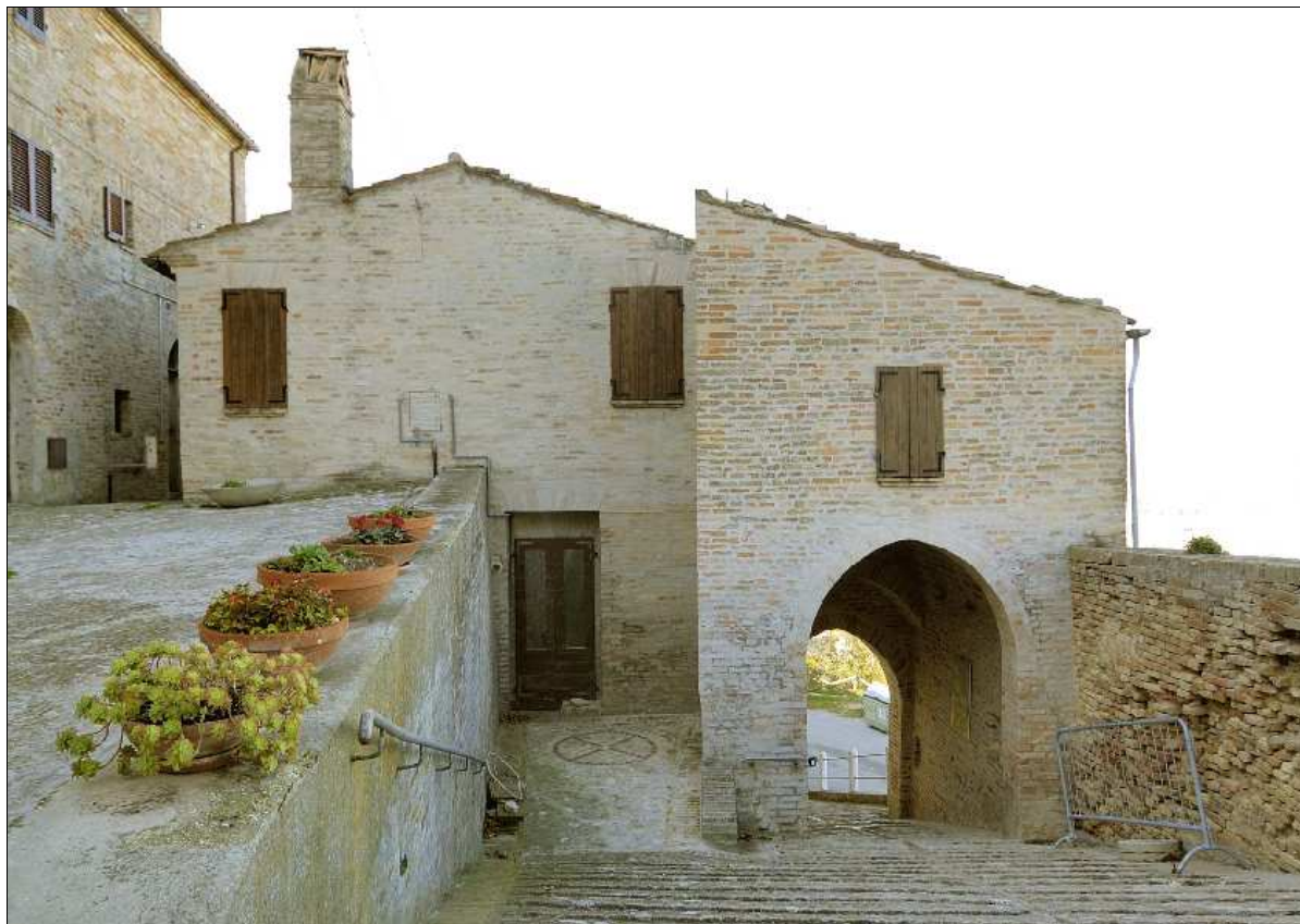
Foto N.: 5 Lato est
