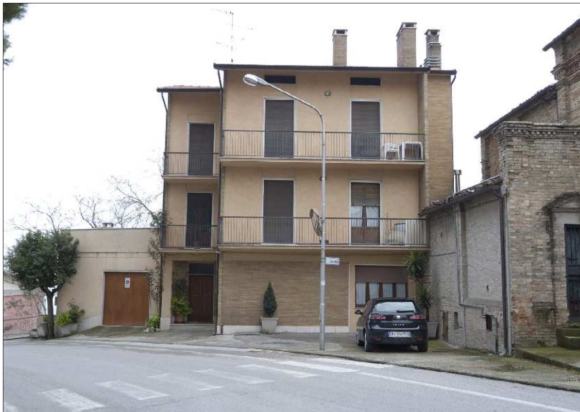
Foto N.: 1 Lato ovest su Viale Adriatico
