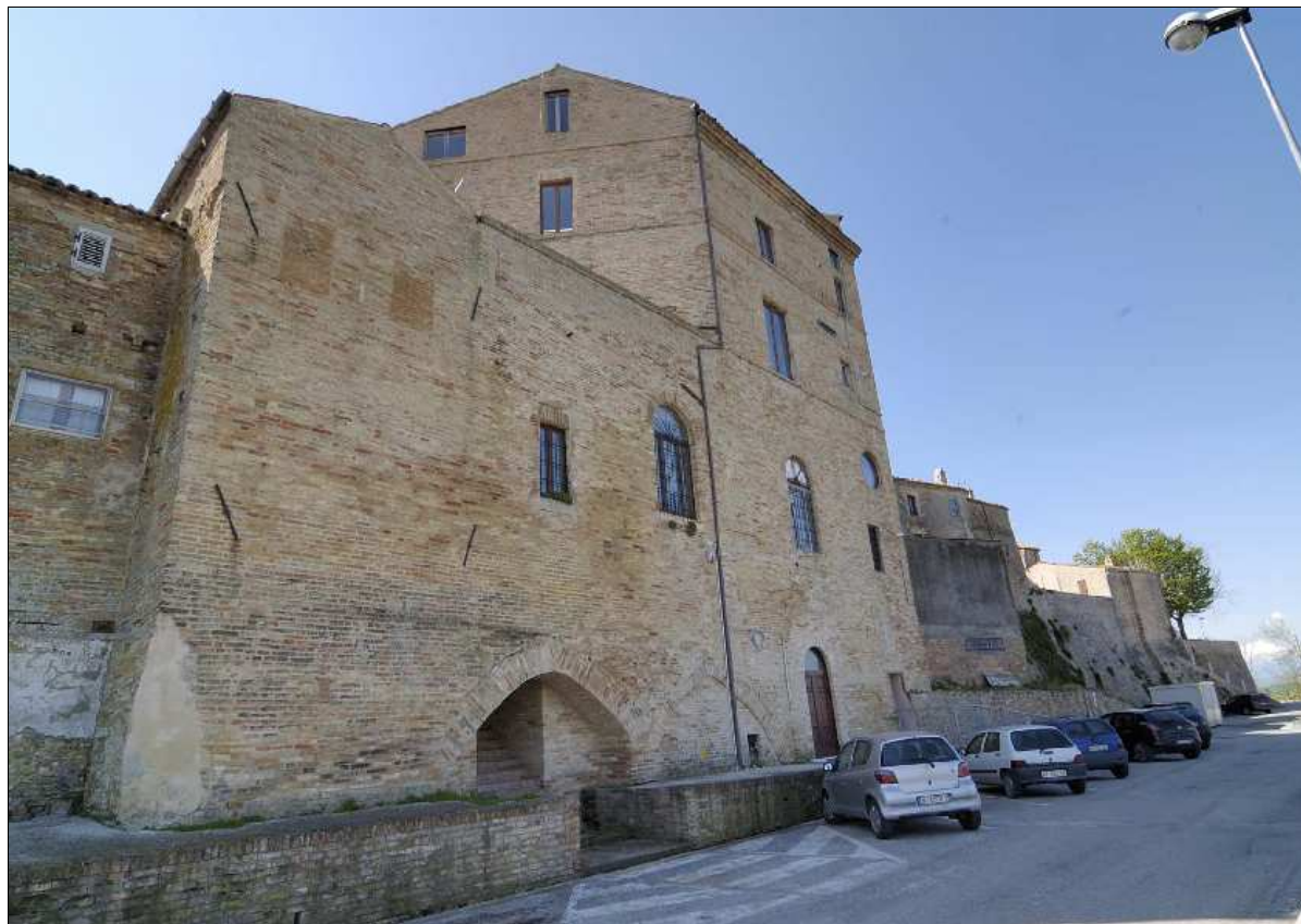
Foto N.: 3 Lato nord su Via Polini
