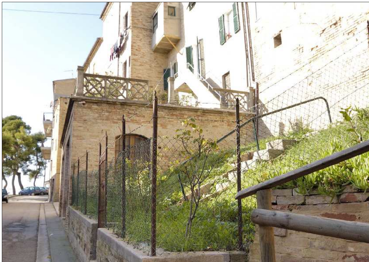
Foto N.: 3 Lato est
