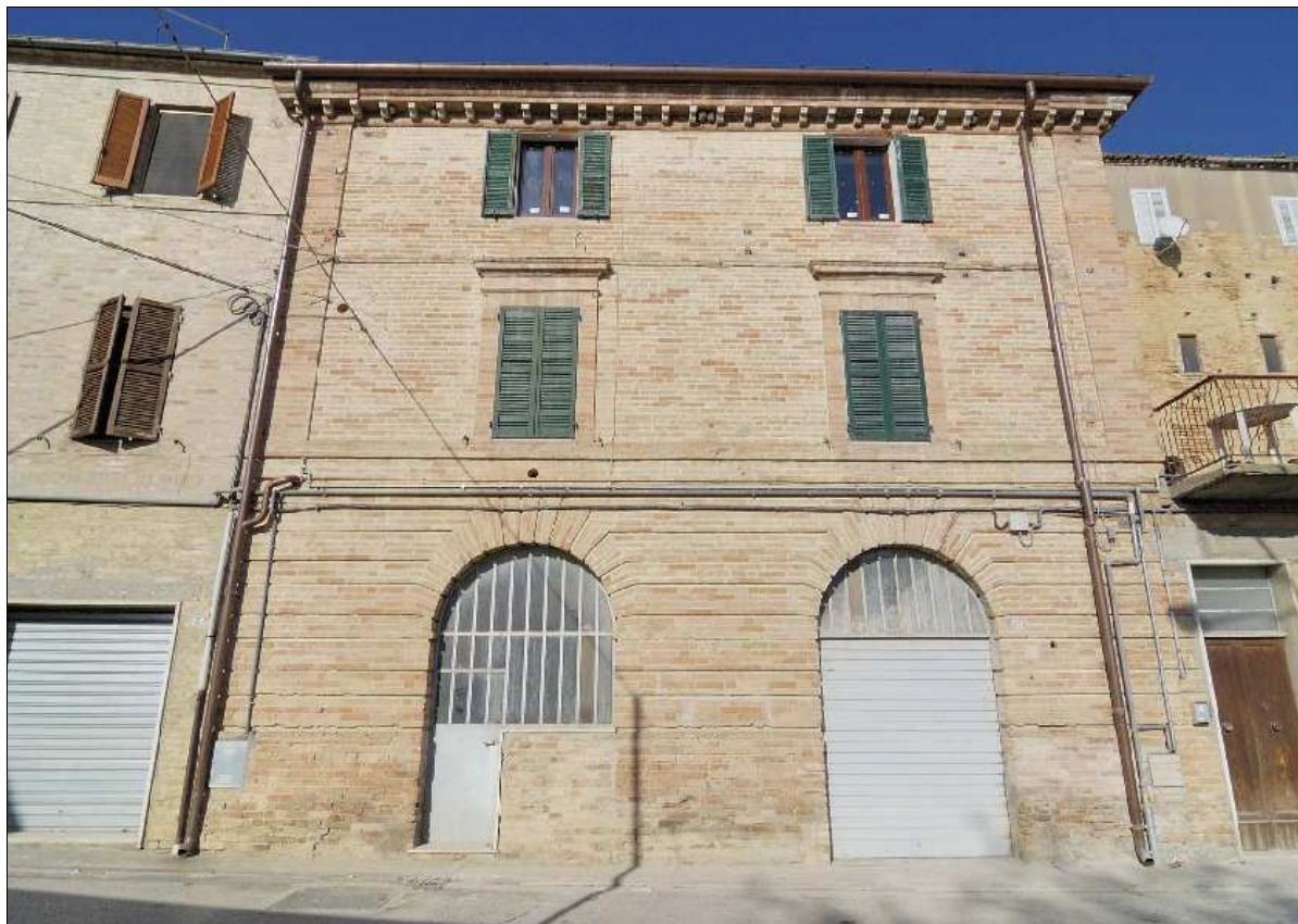
Foto N.: 1 Lato sud su Via Indipendenza
