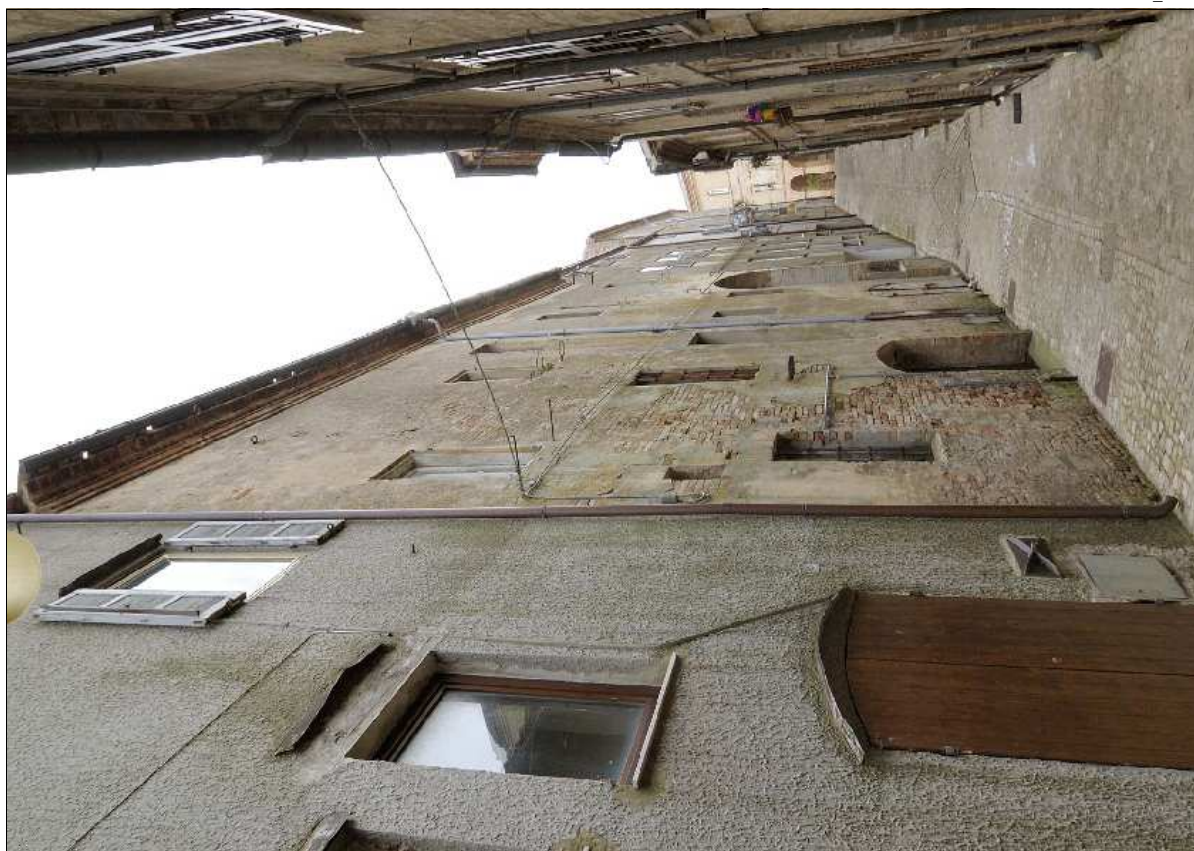
Foto N.: 4 Lato nord su Via Garibaldi
