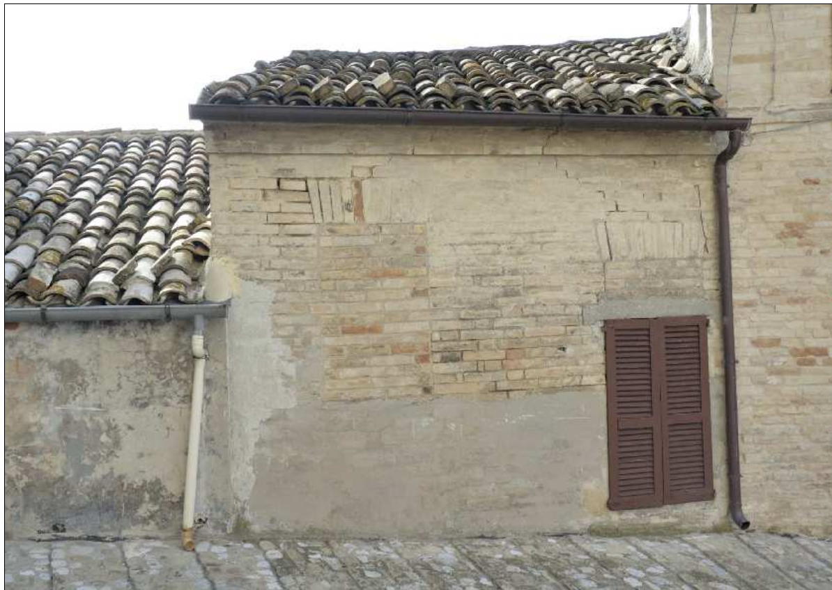
Foto N.: 2 Lato nord su Via Boffo
