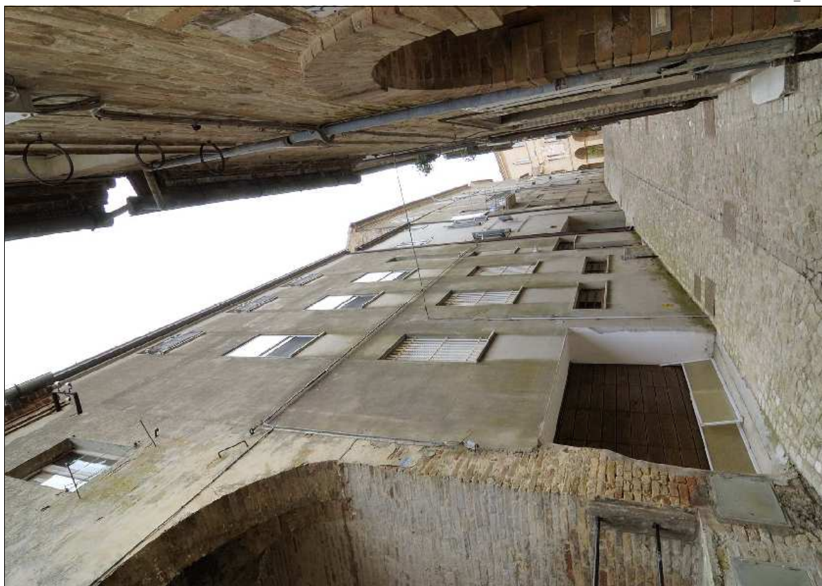
Foto N.: 4 Lato nord su Via Garibaldi
