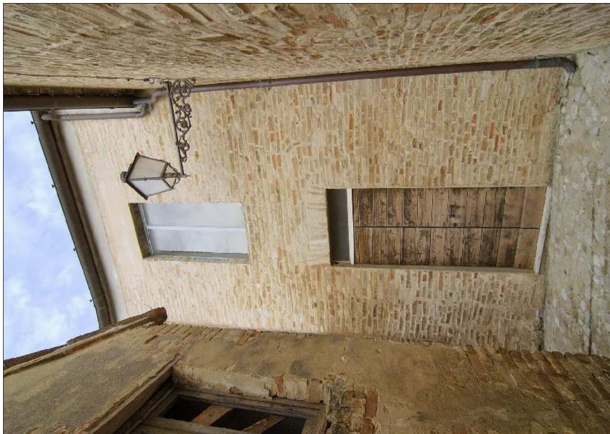
Foto N.: 5 Lato sud in sequenza con la n. 6 e 7
