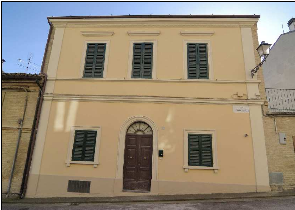
Foto N.: 1 Lato nord su Via Indipendenza
