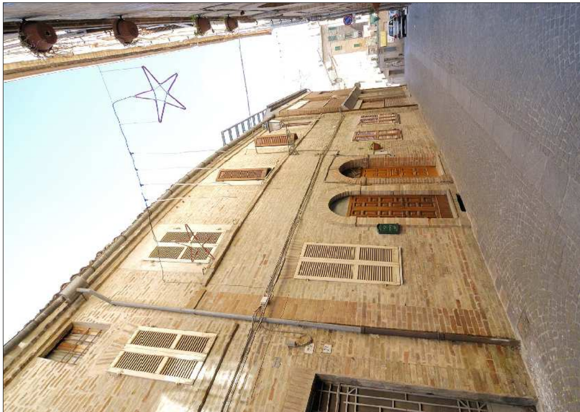
Foto N.: 2 Lato nord su Via Roma
