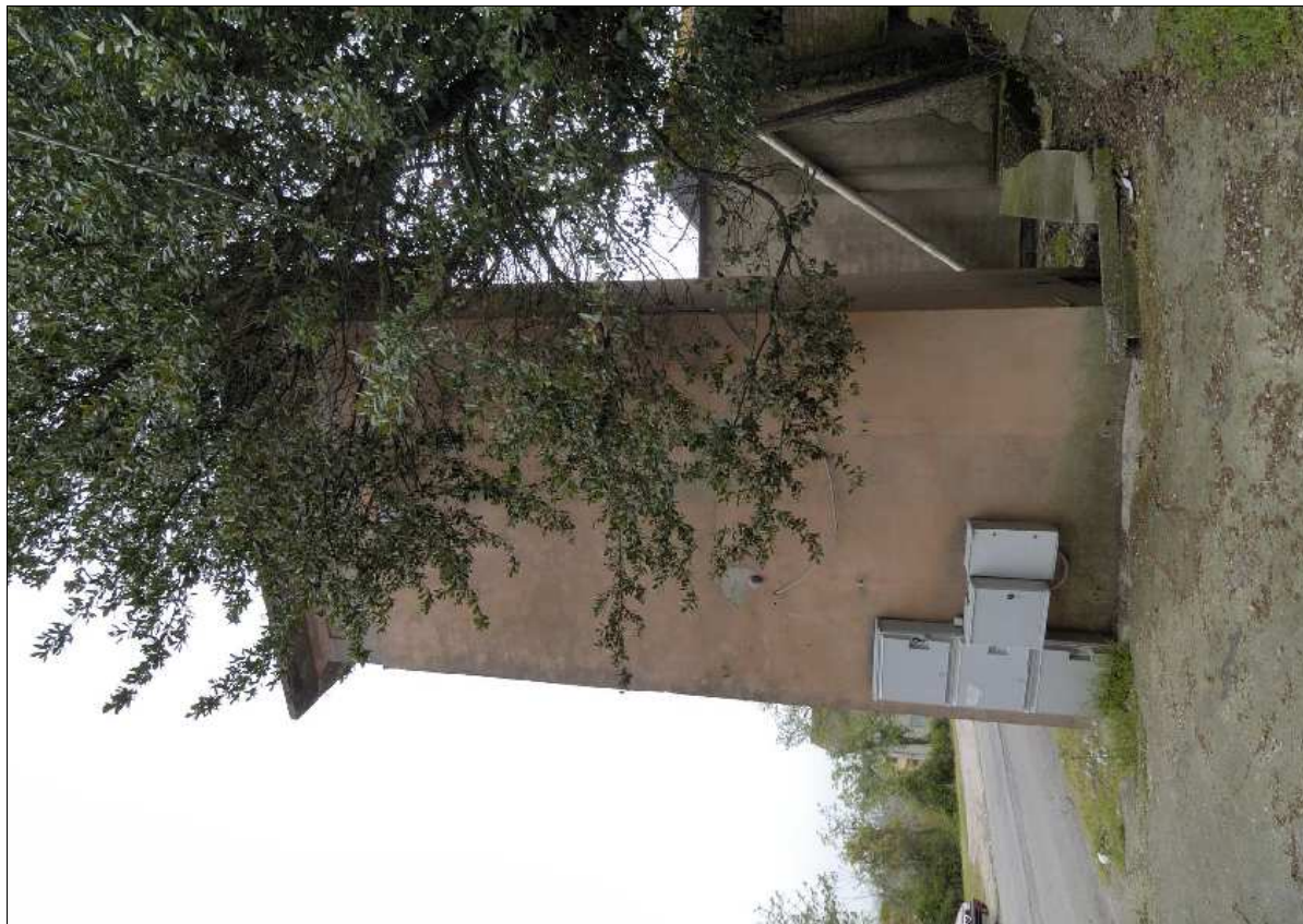
Foto N.: 2 Lato sud-ovest
