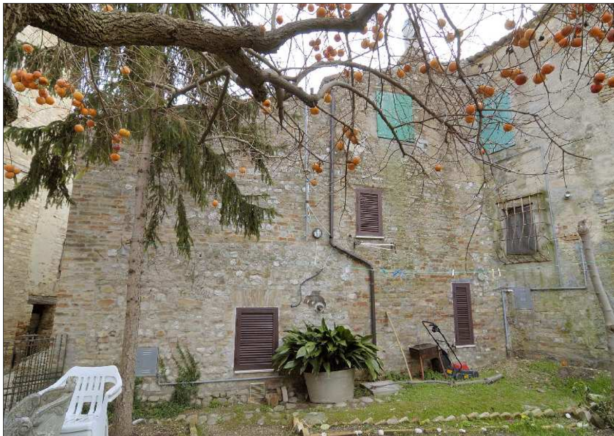
Foto N.: 3 Lato nord su corte
