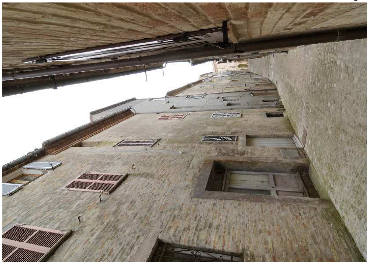
Foto N.: 4 Lato nord su Via Garibaldi
