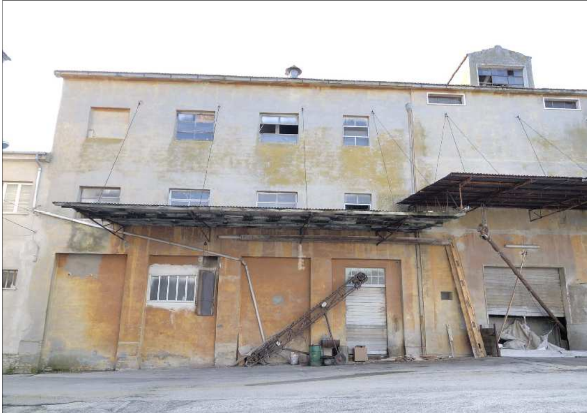
Foto N.: 8 Lato est su Via Risorgimento
