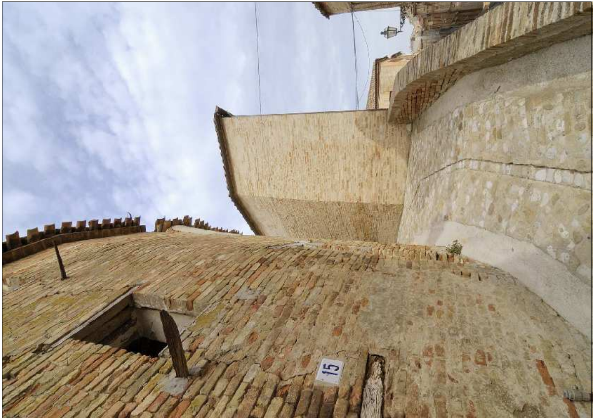
Foto N.: 2 Lato ovest
