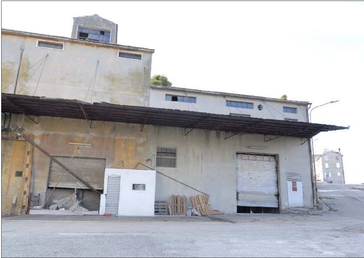
Foto N.: 7 Lato est su Via Risorgimento
