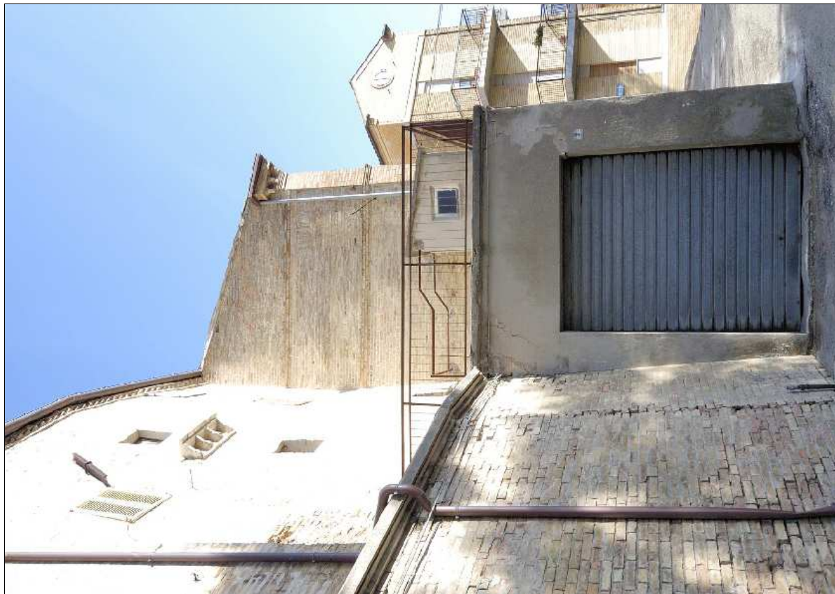
Foto N.: 2 Lato ovest
