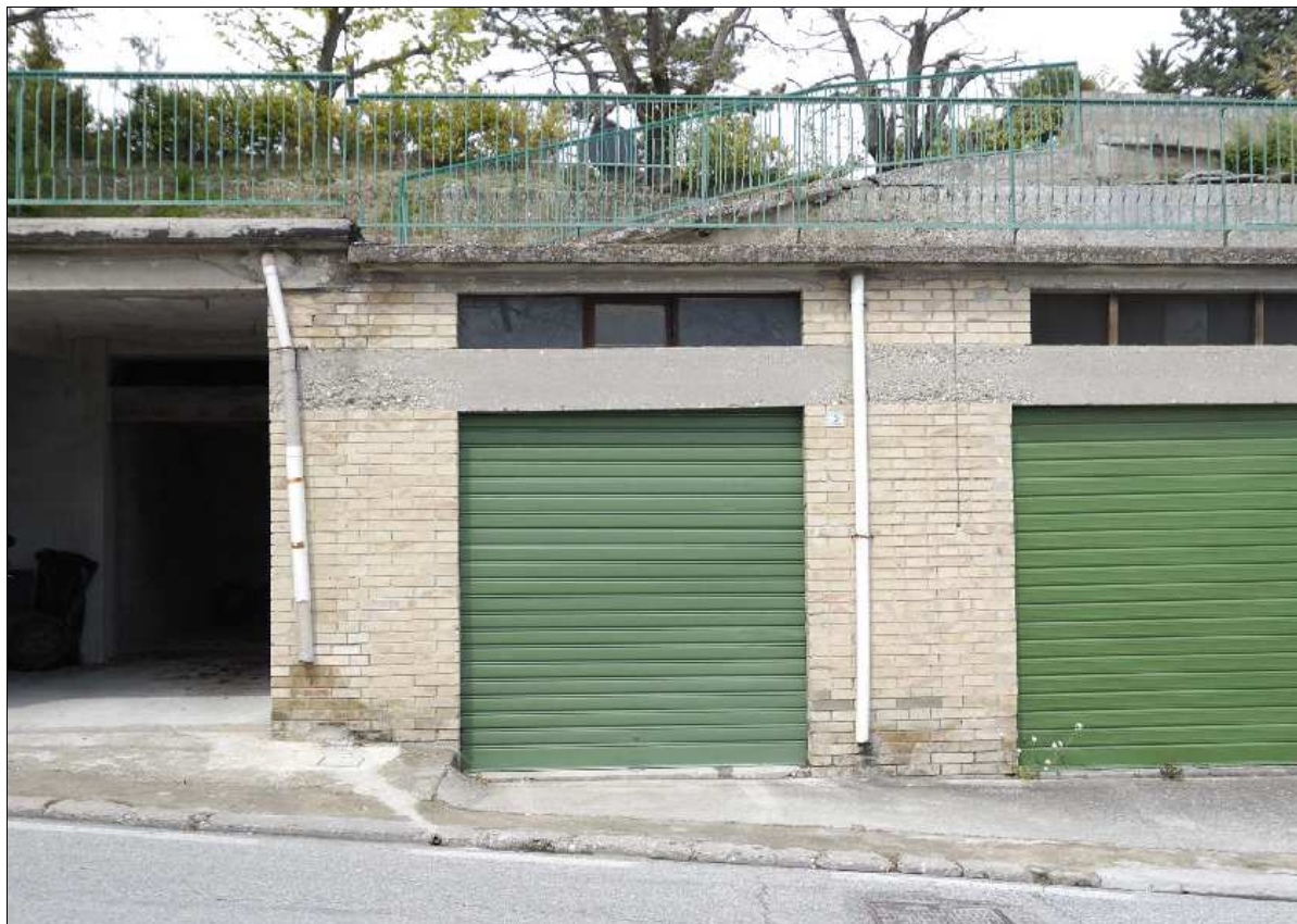
Foto N.: 1 Lato sud su Viale Adriatico
