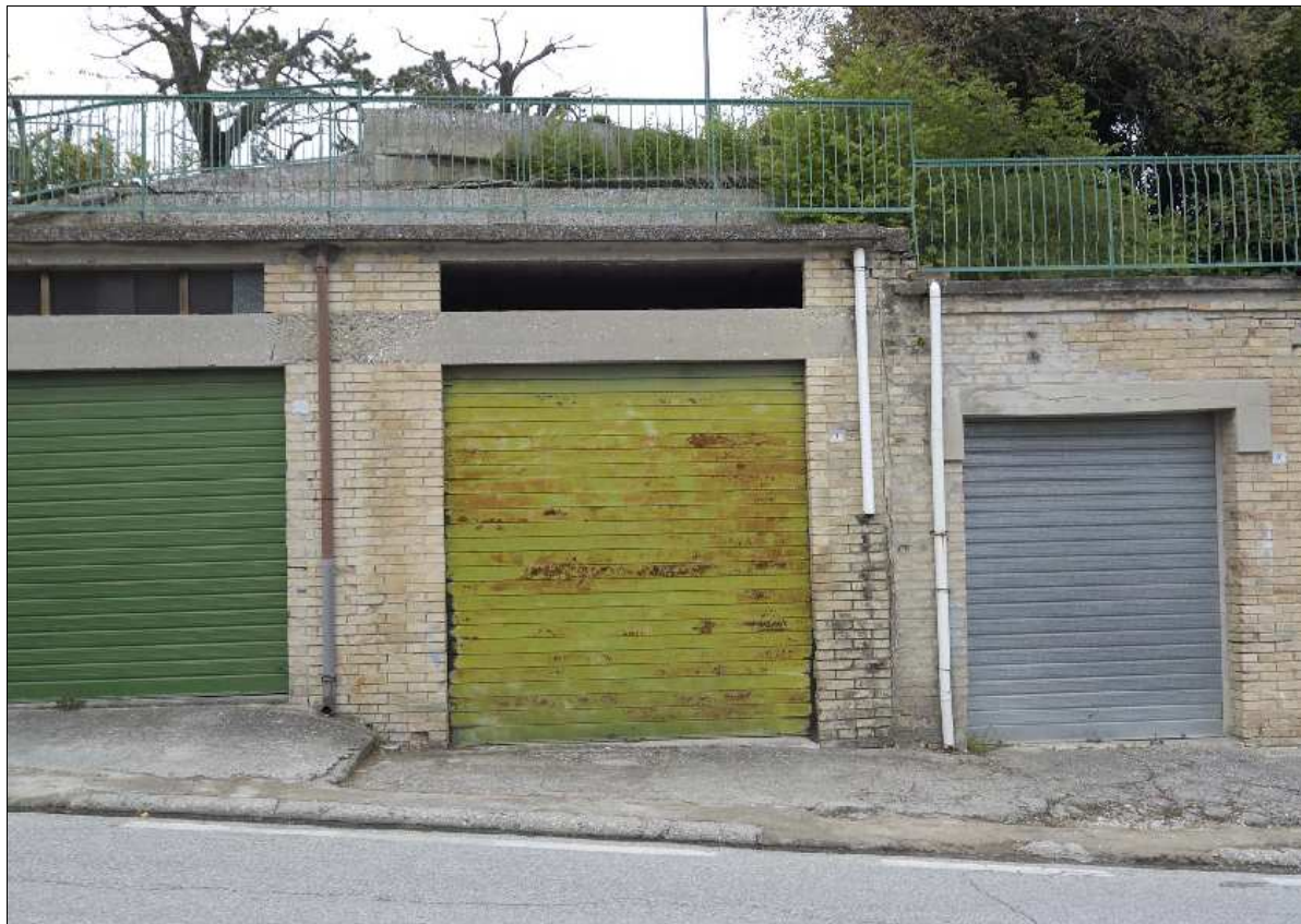
Foto N.: 2 Lato sud su Viale Adriatico
