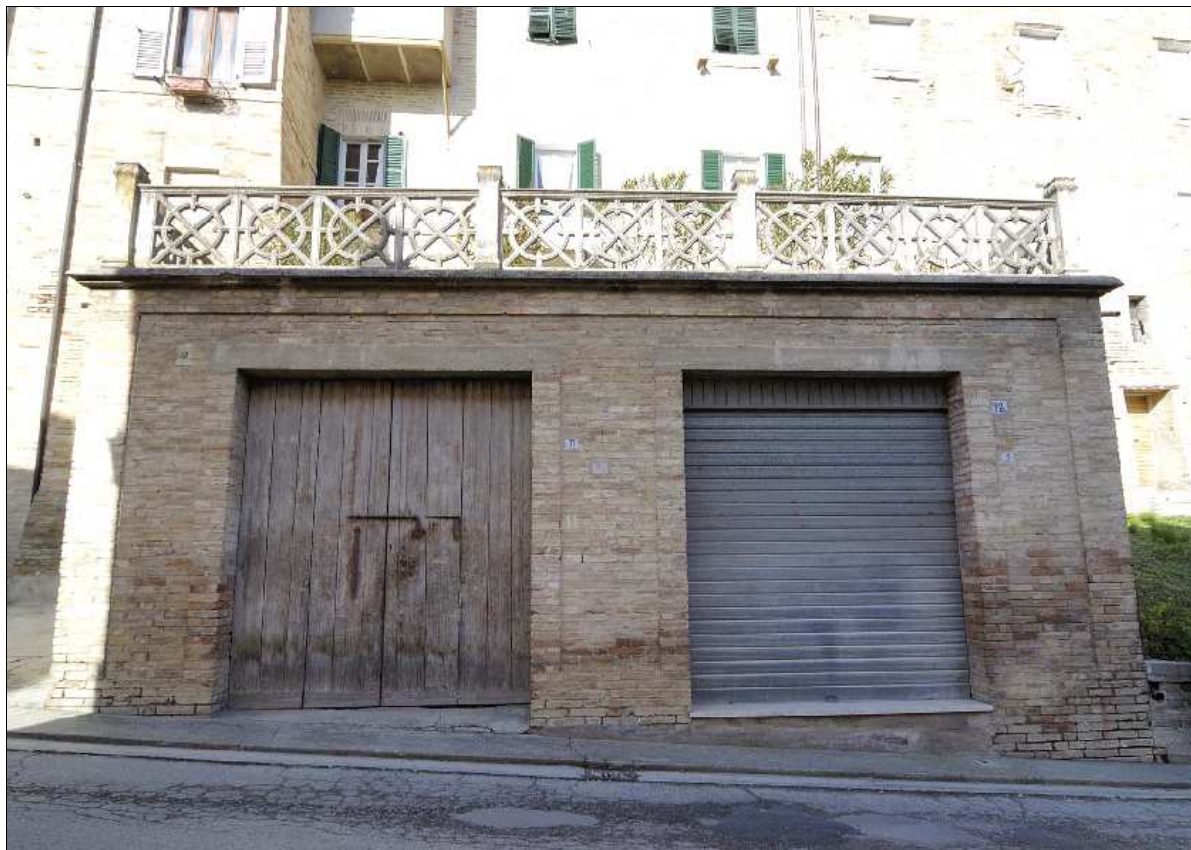
Foto N.: 1 Lato sud su Via Indipendenza
