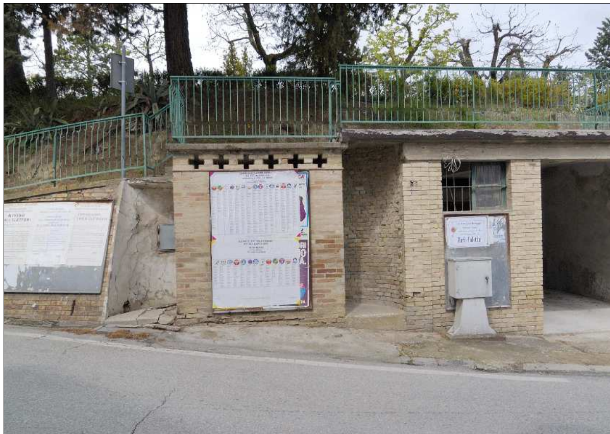
Foto N.: 1 Lato sud su Viale Adriatico
