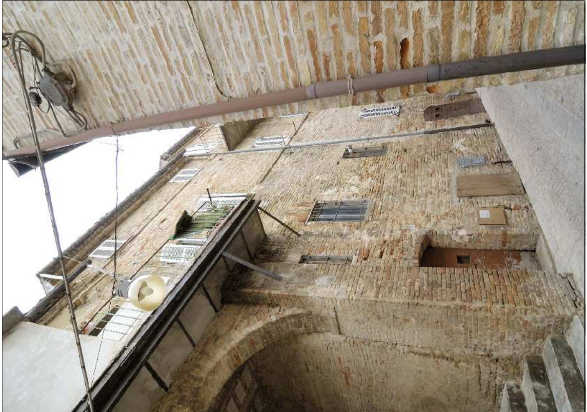
Foto N.: 4 Lato sud su Via C. Battisti
