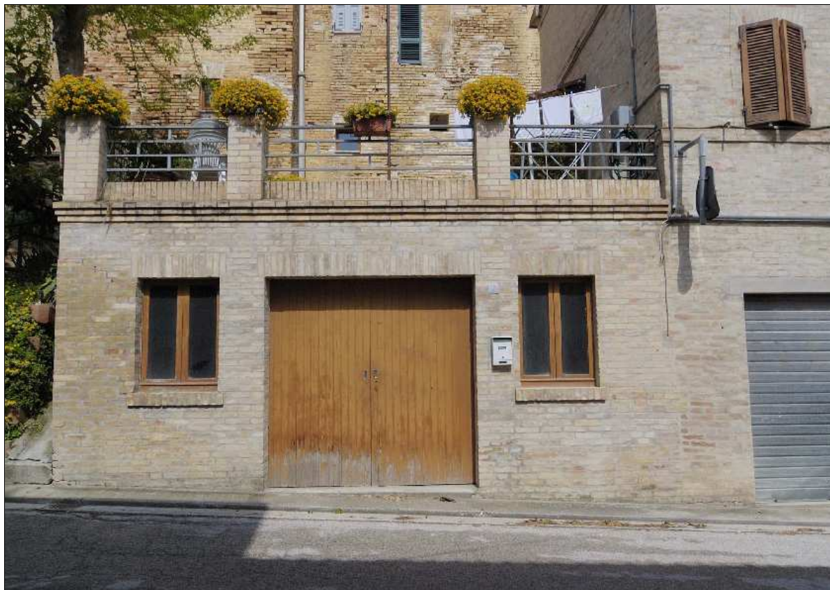
Foto N.: 1 Lato sud su Via Indipendenza
