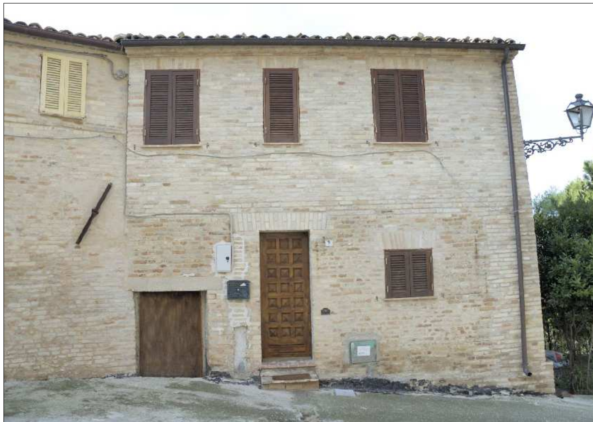
Foto N.: 1 Lato nord su Via Boffo
