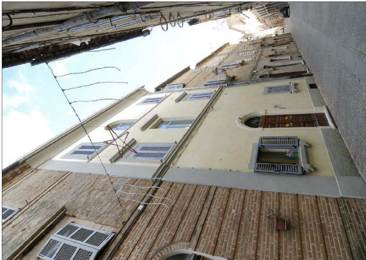
Foto N.: 2 Lato nord su Via Roma
