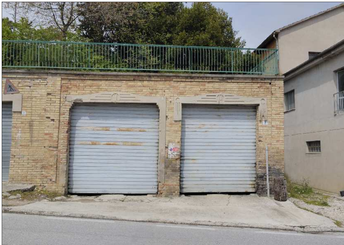
Foto N.: 1 Lato sud su Viale Adriatico
