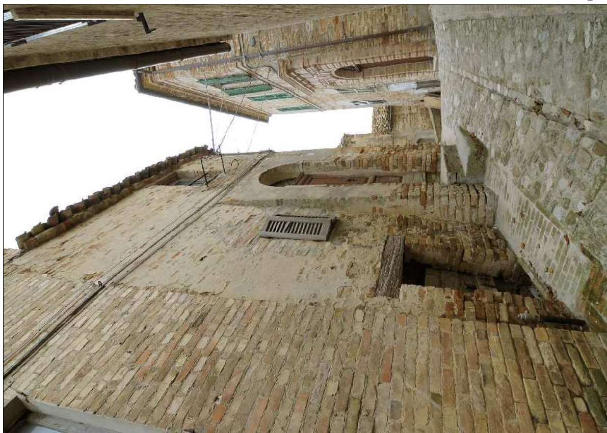
Foto N.: 4 Lato ovest su Via Pichelli
