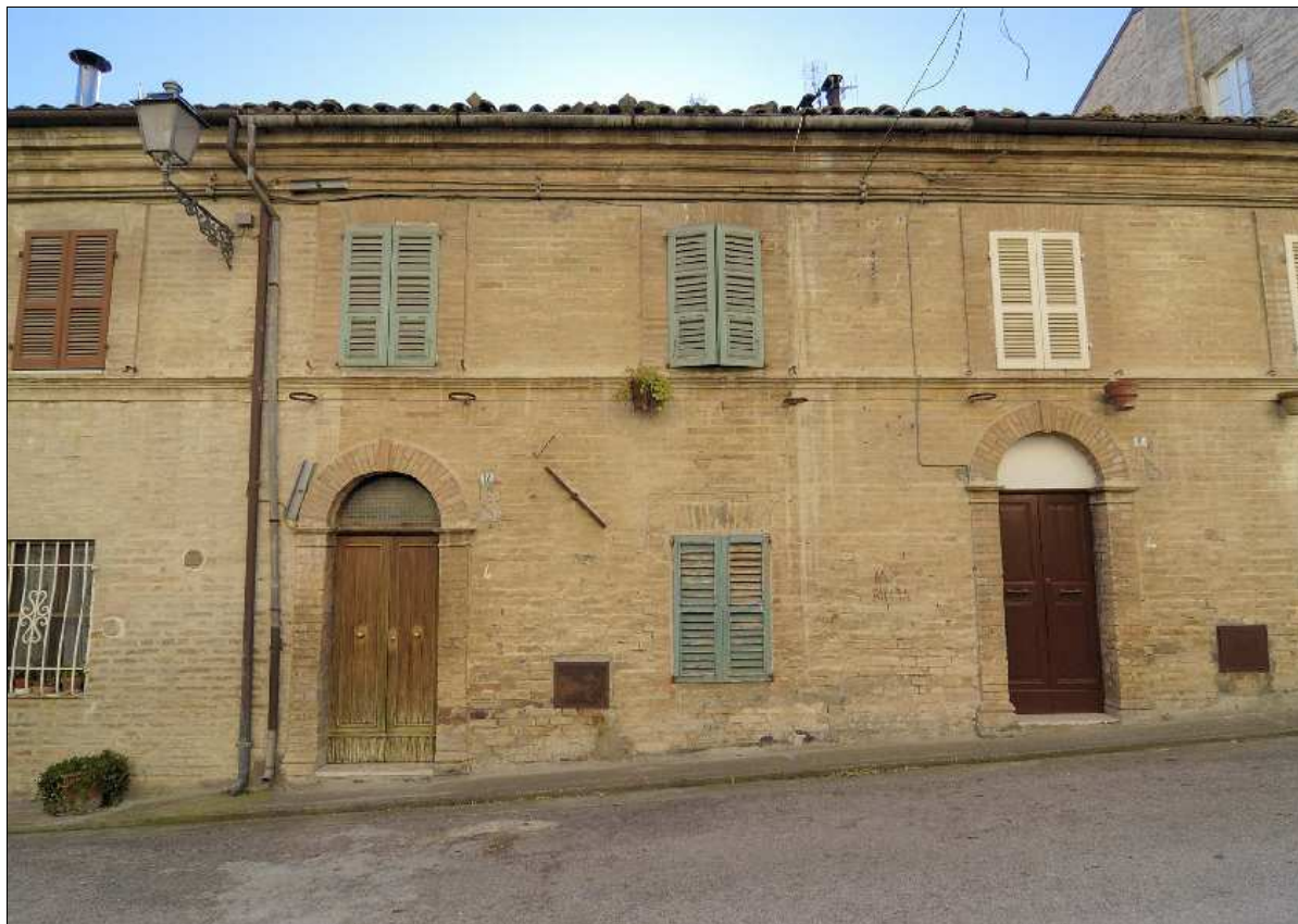
Foto N.: 1 Lato nord su Via Indipendenza
