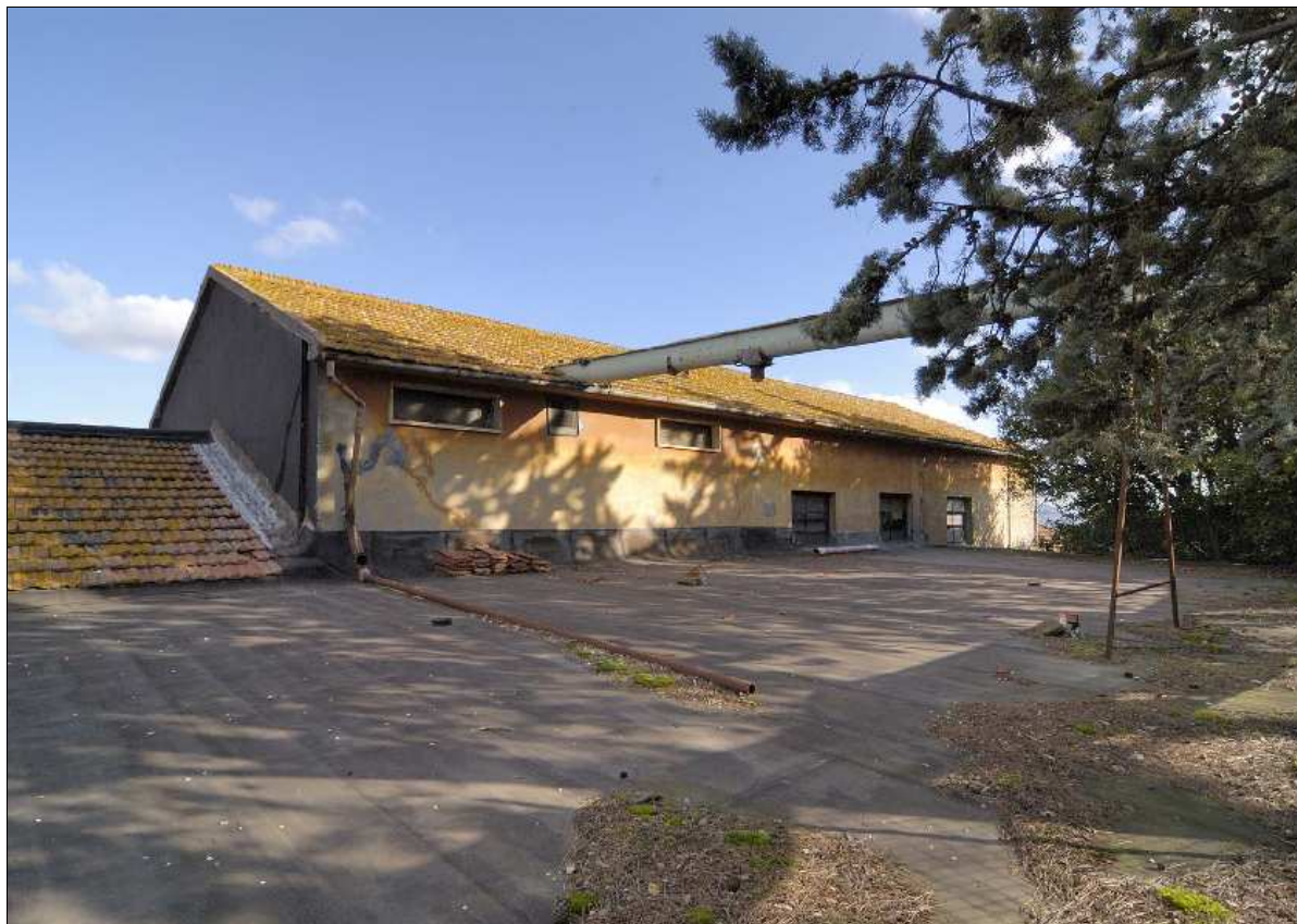
Foto N.: 3 Lato ovest
