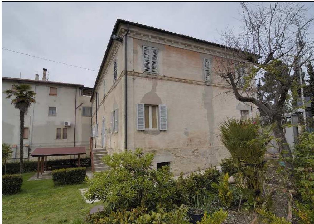
Foto N.: 2 Lato est
