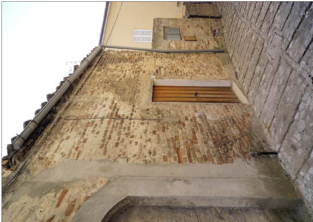
Foto N.: 2 Lato nord su Via Boffo
