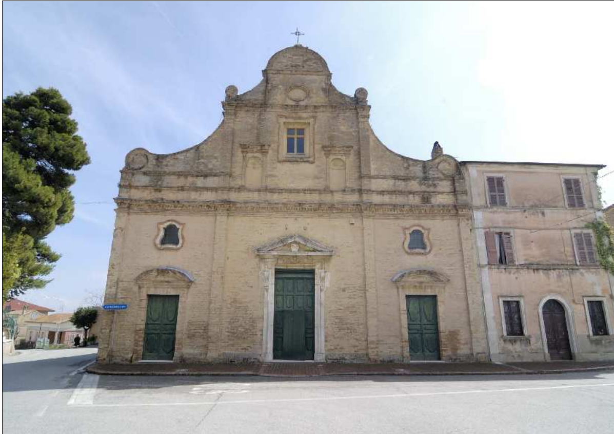
Foto N.: 1 Lato ovest prospetto principale su Piazza Santa M.
