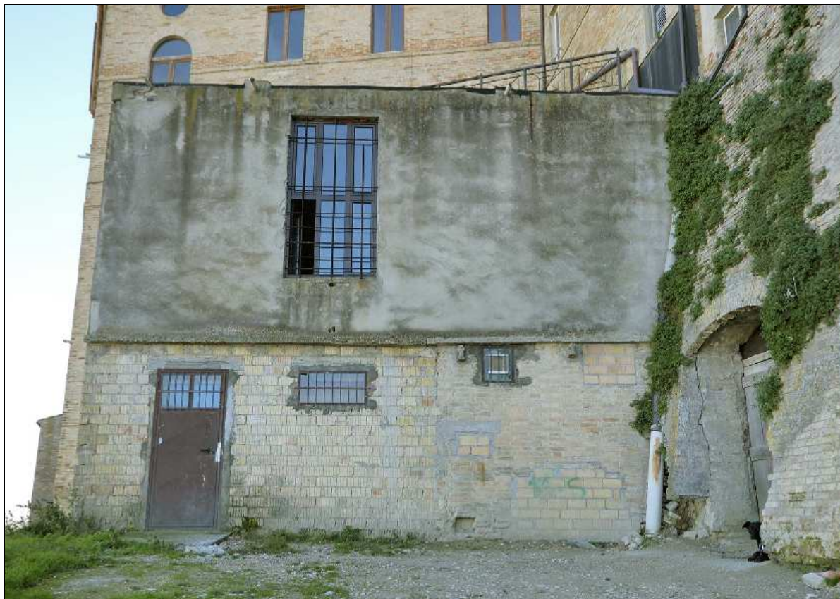
Foto N.: 1 Lato ovest
