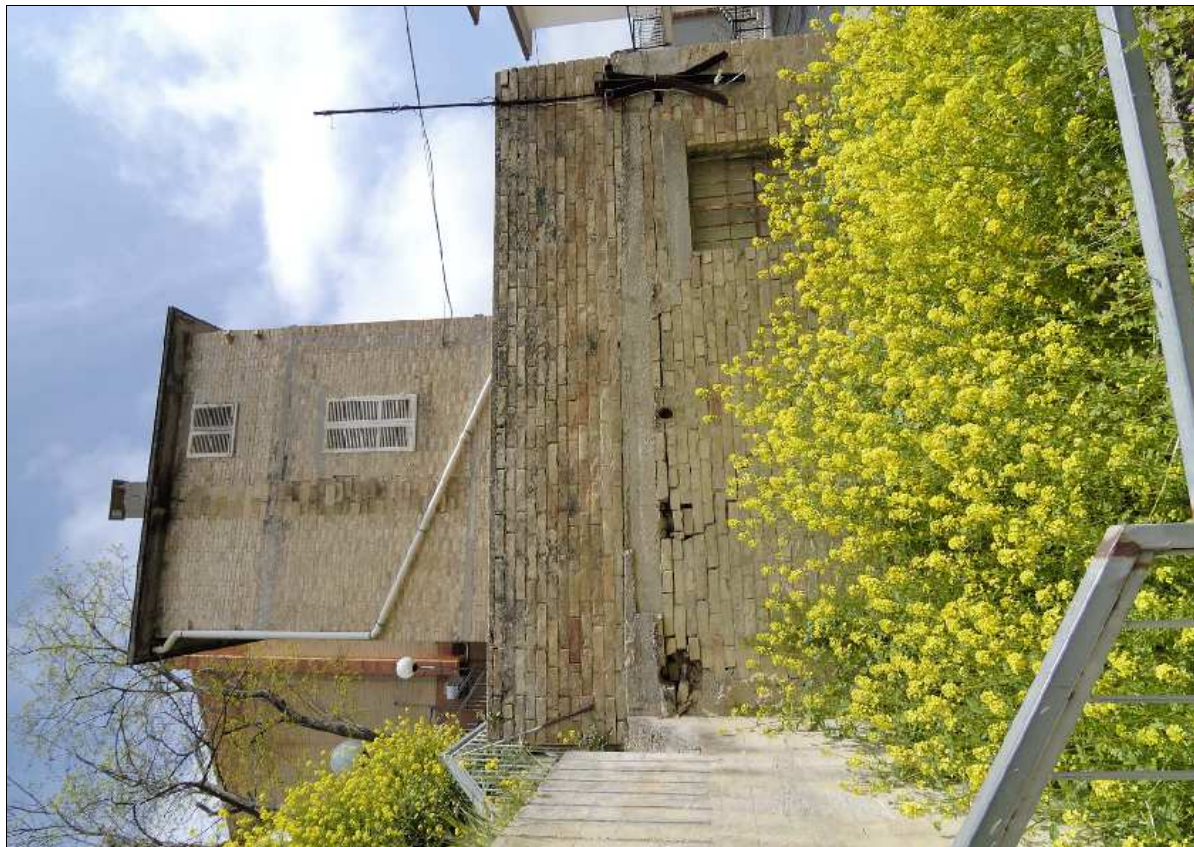
Foto N.: 2 Lato ovest
