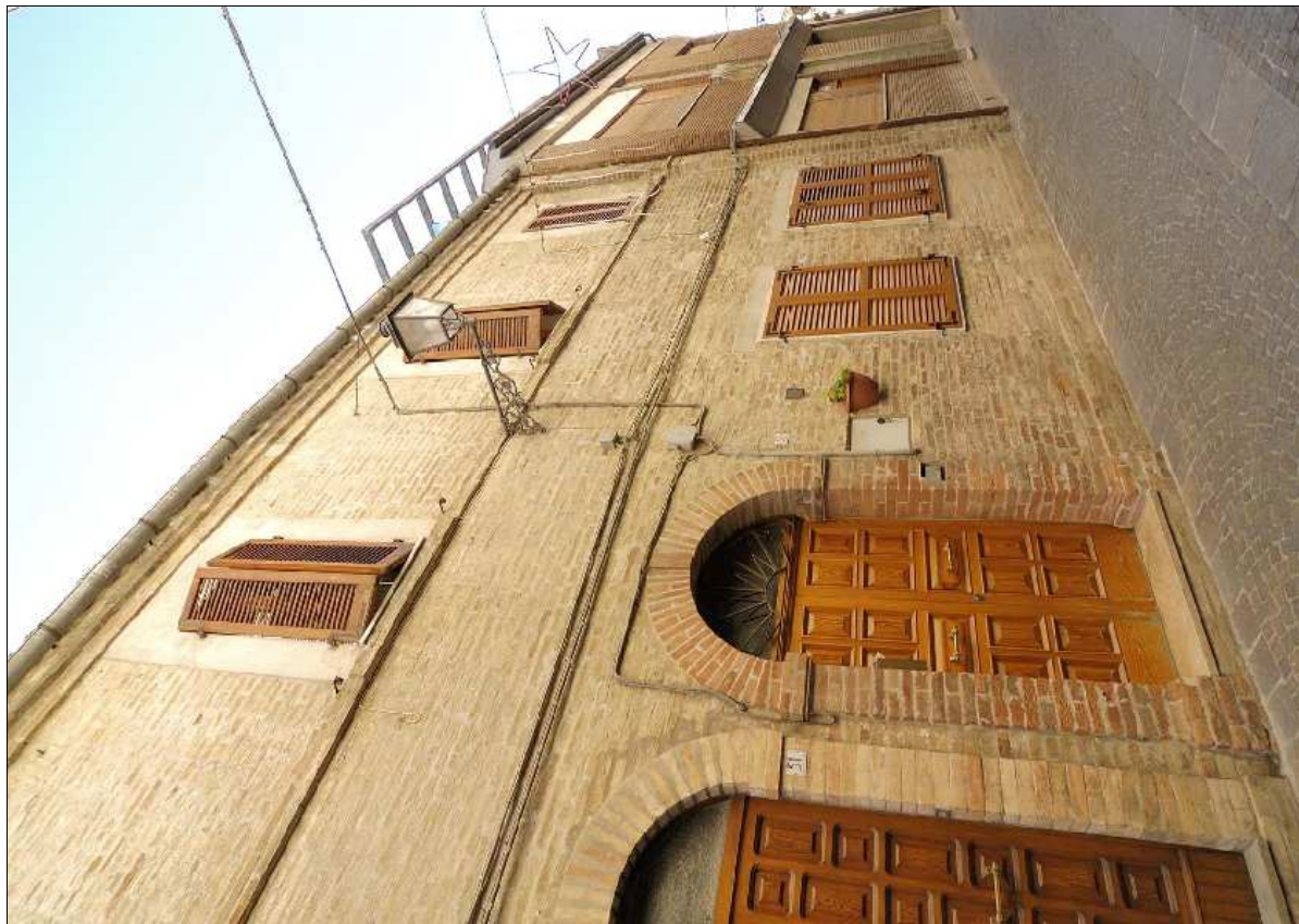
Foto N.: 2 Lato nord su Via Roma
