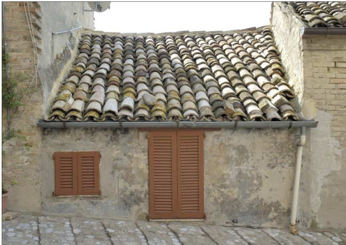
Foto N.: 2 Lato nord su Via Boffo
