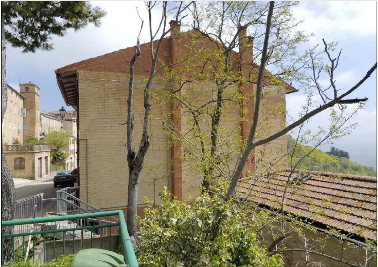
Foto N.: 3 Lato ovest
