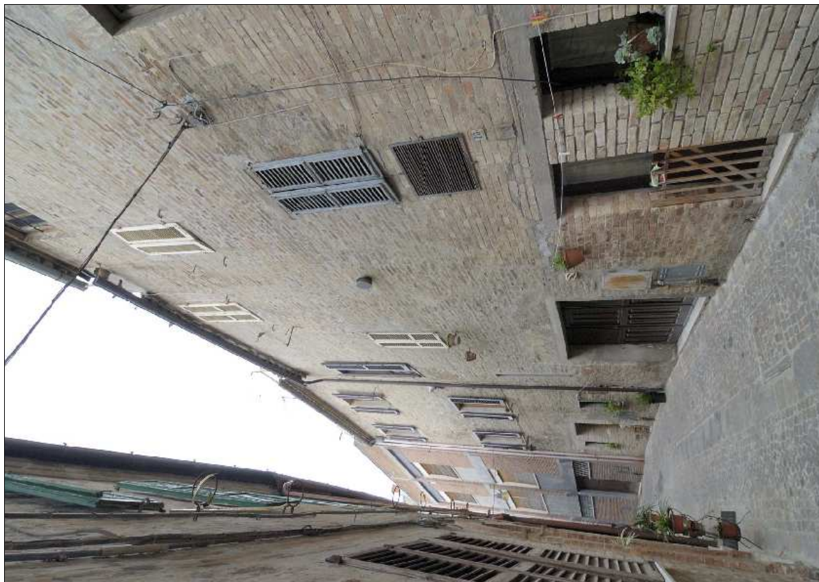
Foto N.: 5 Lato sud su Via C. Battisti
