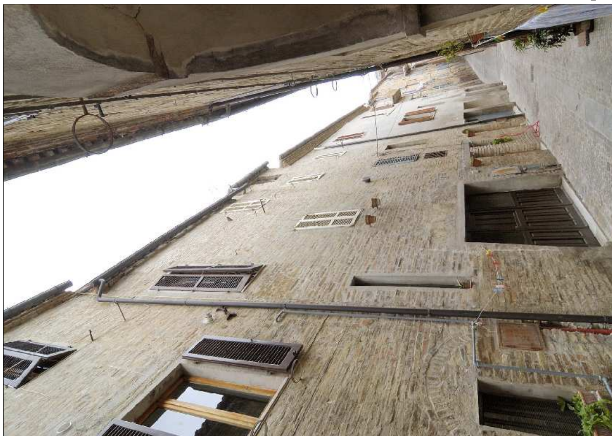
Foto N.: 6 Lato sud su Via C. Battisti
