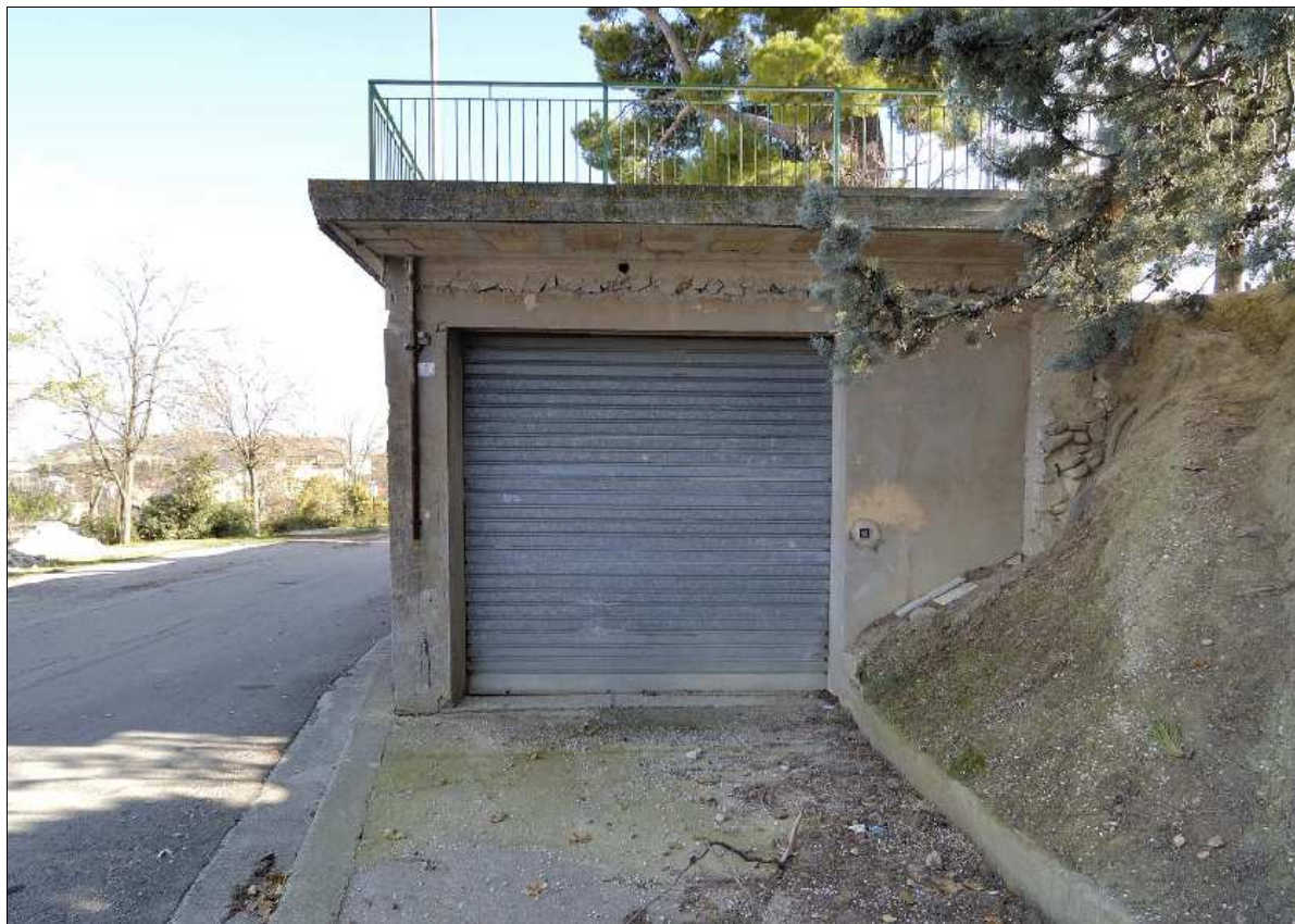
Foto N.: 1 Lato ovest
