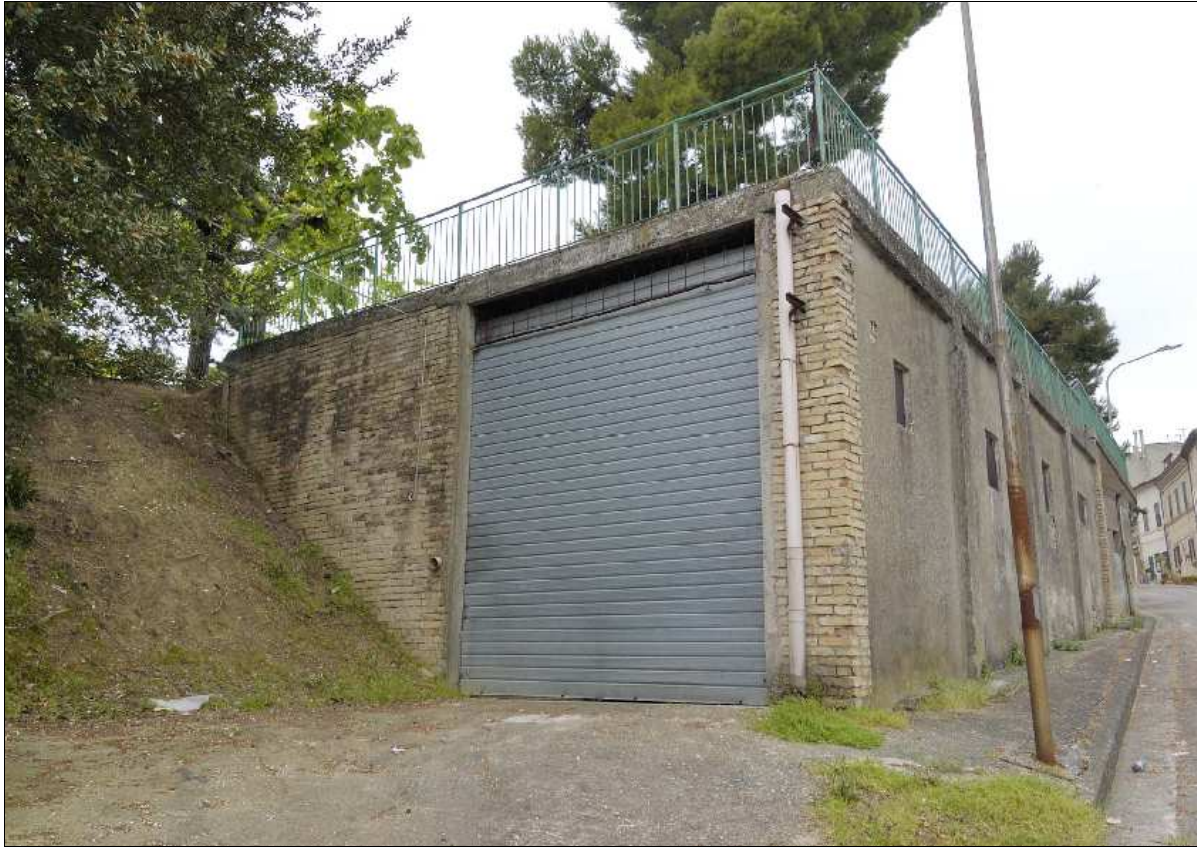
Foto N.: 1 Lato est
