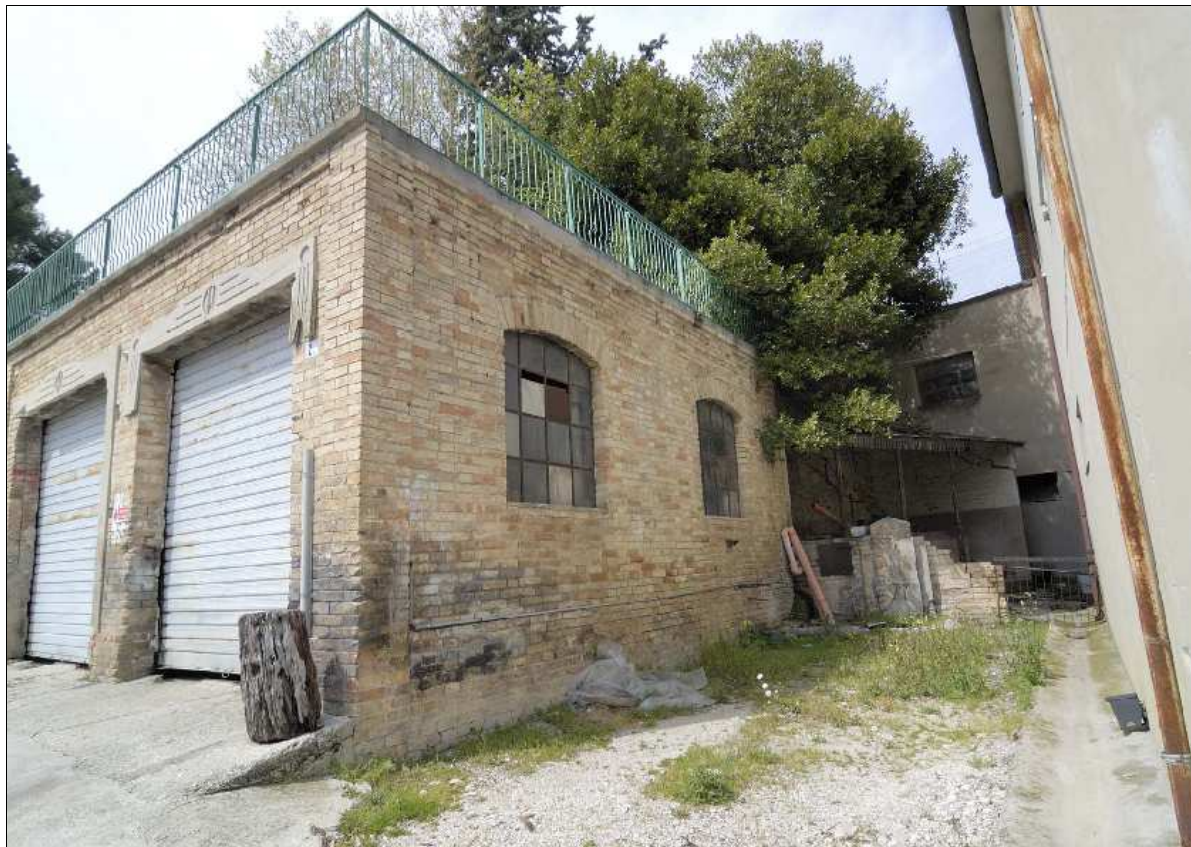
Foto N.: 2 Lato est
