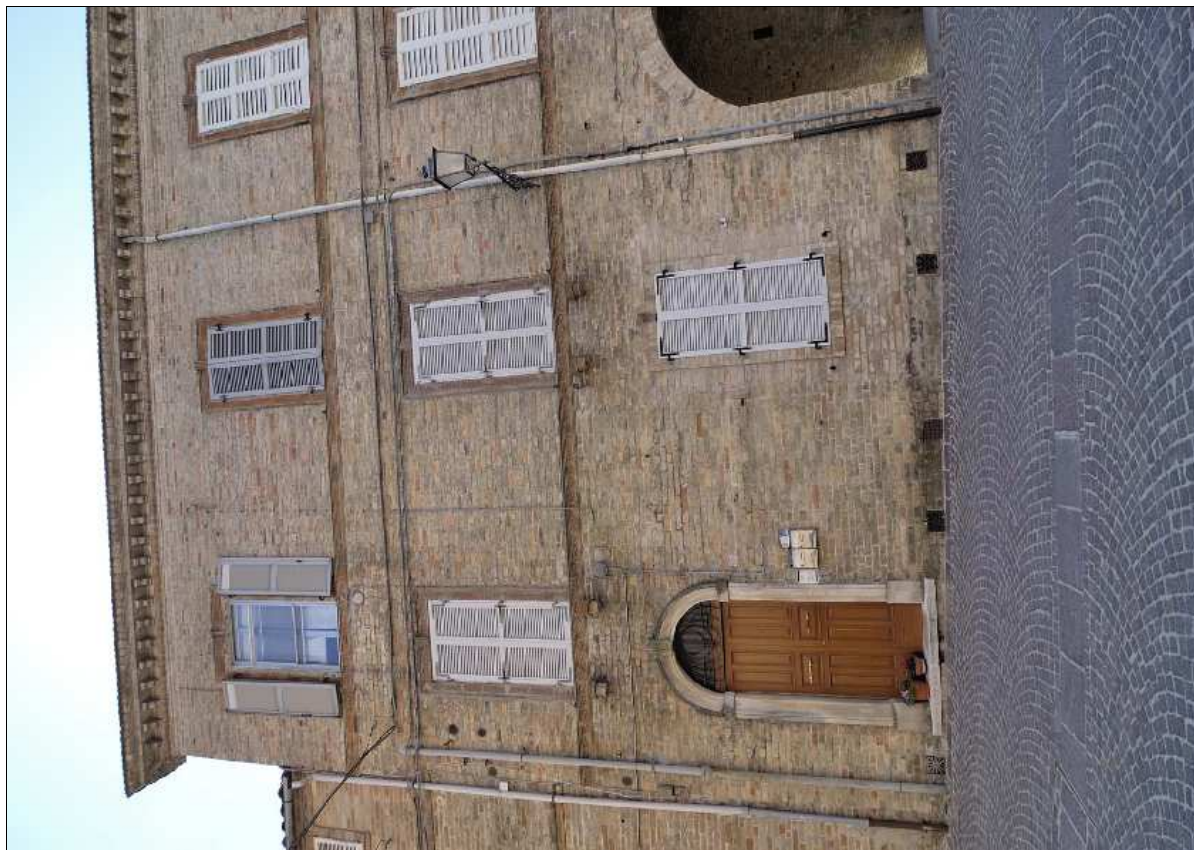
Foto N.: 1 Lato nord su Via Roma
