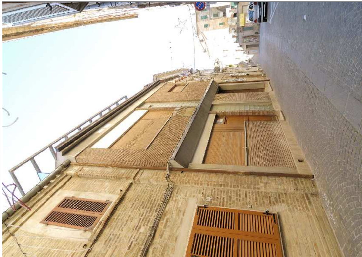
Foto N.: 2 Lato nord su Via Roma
