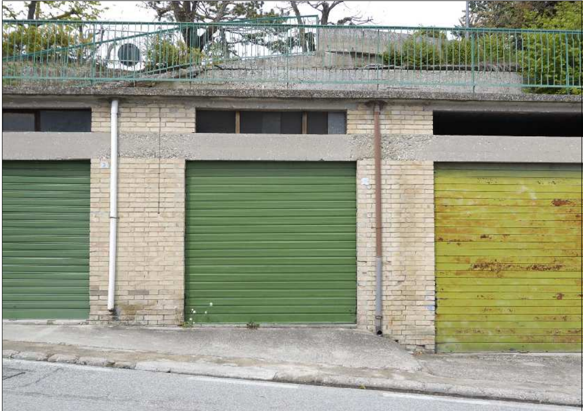
Foto N.: 1 Lato sud su Viale Adriatico
