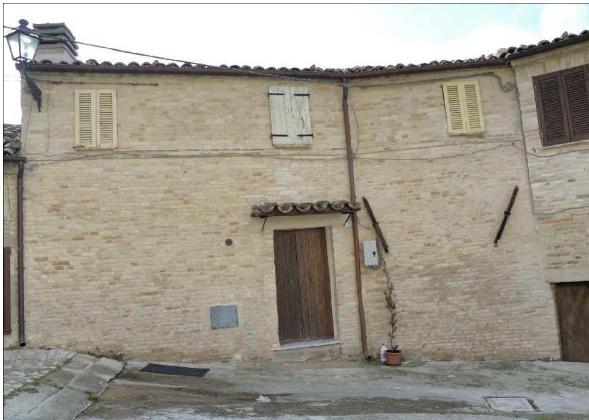
Foto N.: 1 Lato nord su Via Boffo
